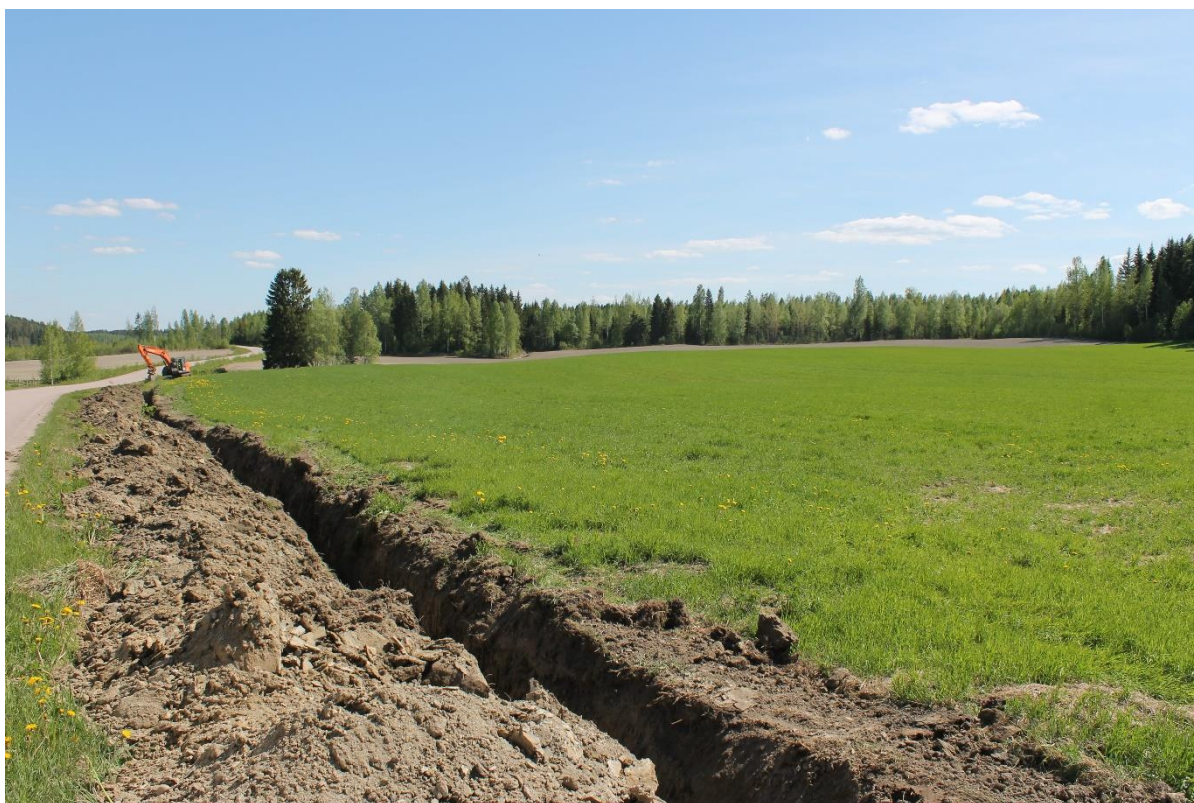
Kuva 6-10. Esimerkkikuva maakaapelin kaapeliojan kaivuutyöstä, Ratiperän tuulivoimapuisto Jämijärvellä (Kuva: ABO Wind Oy).
