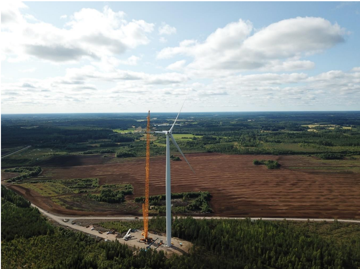
Kuva 6-1. Esimerkkikuva maankäytöstä tuulivoimalan rakentamisvaiheessa, Ratiperän tuulivoimapuisto Jämijärvellä (Kuva: ABO Wind Oy).
