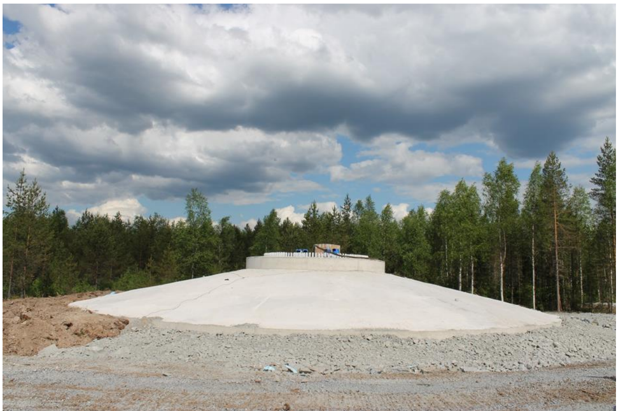
Kuva 6-4. Esimerkkikuva tuulivoimalan teräsbetoniperustuksesta, Silovuoren tuulivoimapuisto Pyhäjoella (Kuva: ABO Wind Oy).
