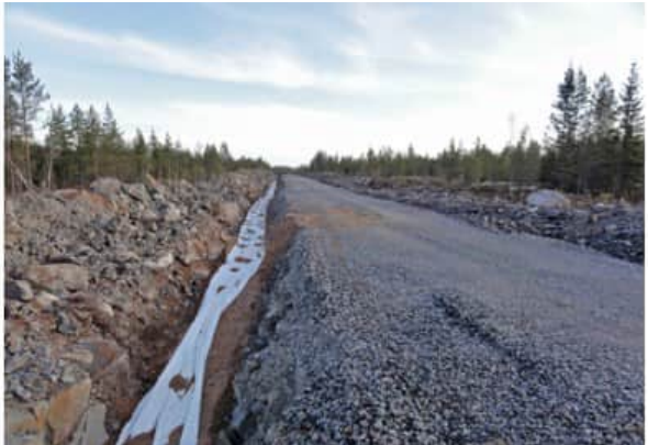
Kuva 4.12 Maakaapelit upotetaan huoltoteiden yhteyteen (FCG Finnish Consulting Group Oy).
