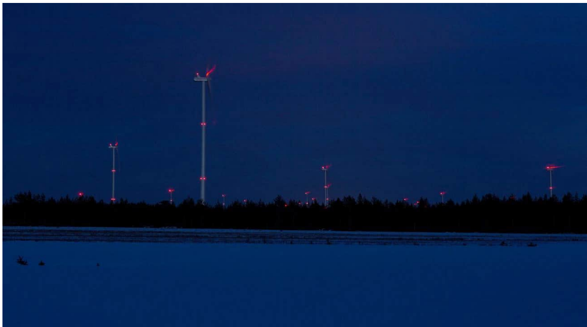
Kuva 4.5 Kiinteät punaiset lentoestevalot (FCG Finnish Consulting Group Oy).
