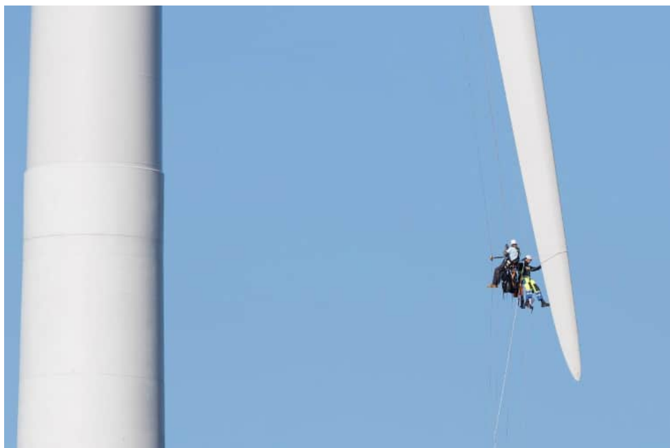
Kuva 4.18 Tuulivoimalan huoltotoimenpiteitä (FCG Finnish Consulting Group Oy).
