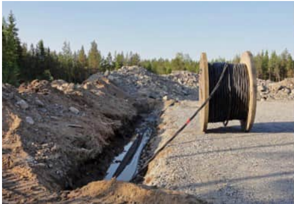
Kuva 4.12 Maakaapelit upotetaan huoltoteiden yhteyteen (FCG Finnish Consulting Group Oy).
