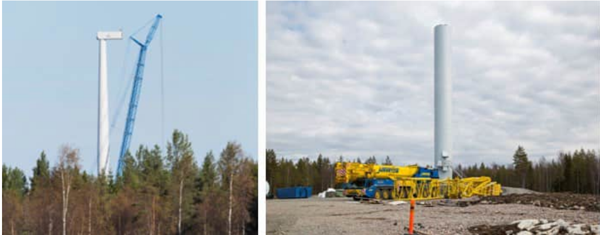
Kuva 4.14 Tuulivoimalan kokoamista (FCG Finnish Consulting Group Oy).
