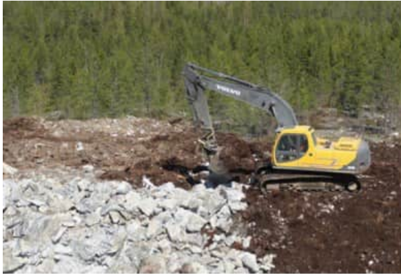
Kuva 4.11 Tuulivoimapuiston rakentaminen alkaa huoltoteiden ja pystytysalueiden rakentamisella (FCG Finnish Consulting Group Oy).
