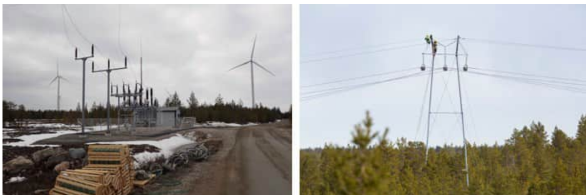
Kuva 4.16 Sähköaseman ja voimajohdon rakentamista (FCG Finnish Consulting Group Oy).
