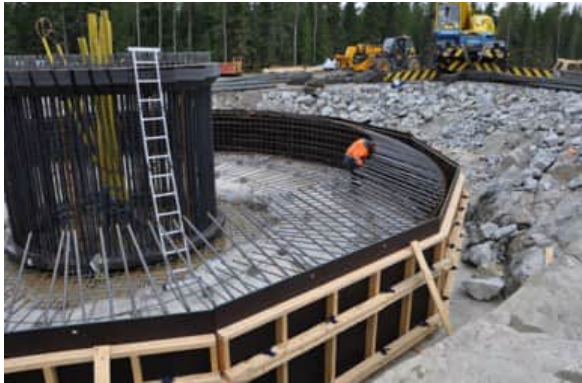
Kuva 4.13 Tuulivoimalan perustusten rakentamista (FCG Finnish Consulting Group Oy).
