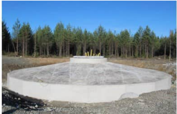
Kuva 4.13 Tuulivoimalan perustusten rakentamista (FCG Finnish Consulting Group Oy).
