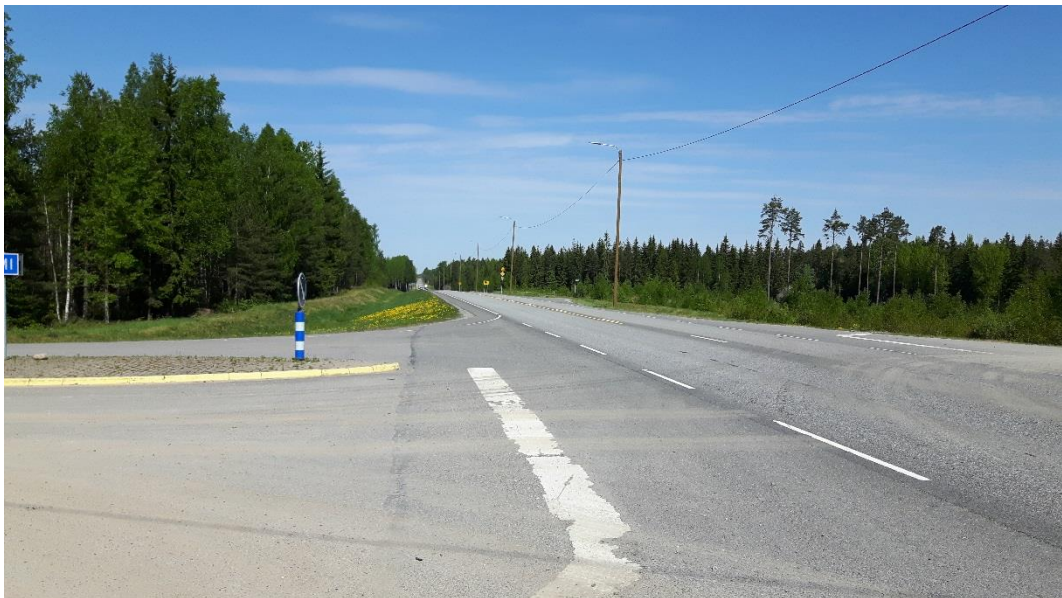
Kuva 14. Näkymä valtatie 8 ja Krouvinummentien risteysalueelta pohjoisen suuntaan (Sweco Ympäristö Oy, 2018).
