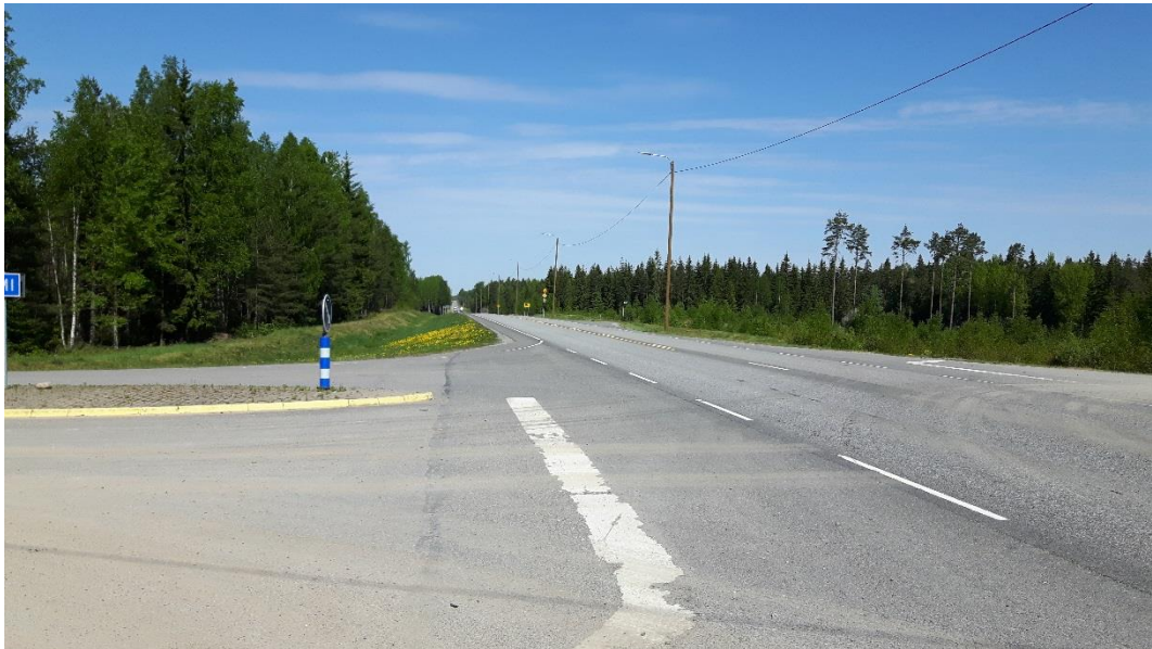
Kuva 16. Näkymä valtatie 8 ja Krouvinummentien risteysalueelta pohjoisen suuntaan (Sweco Ympäristö Oy, 2018).
