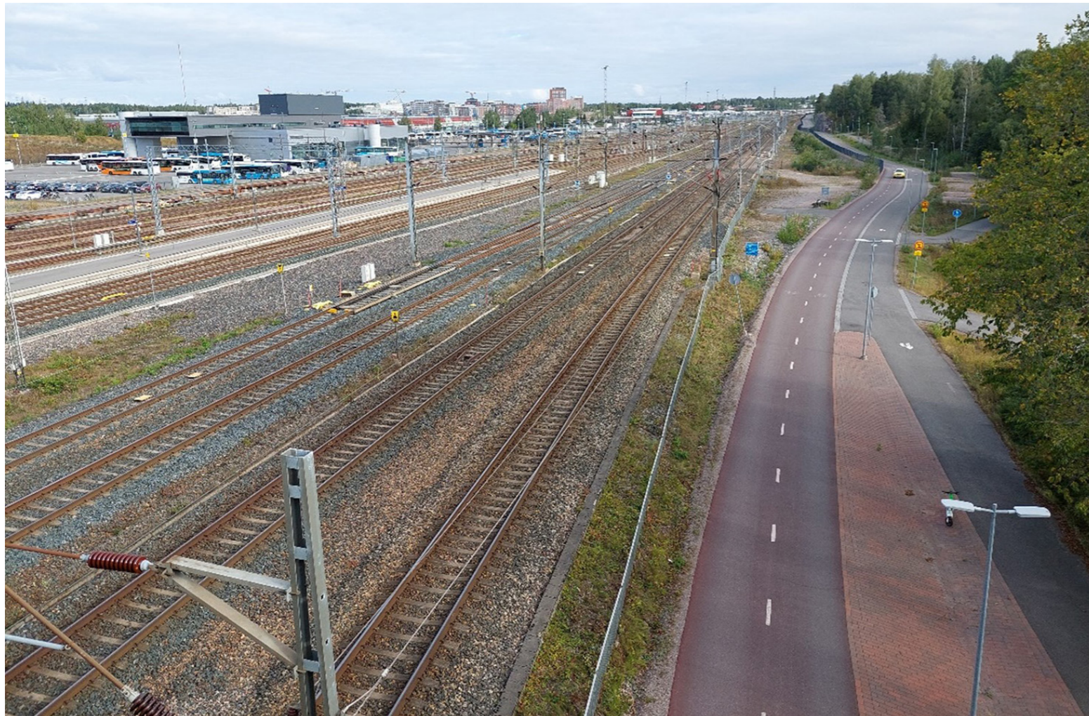
Kuva 2.4 Pasilan / Ilmalan ratapiha Metsämäentien sillalta kuvattuna, oikealla pohjoisbaana (kuva: Sitowise Oy)
