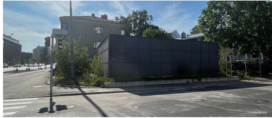
Kuva 2.10 Esimerkki Lahtisaressa sijaitsevasta Länsimetron kuilurakennuksesta, jossa ratatunnelia palvelevaa tekniikkaa on viety mahdollisimman paljon maan alle. Maanpäällisen rakennuksen pituus on noin 16 metriä, leveys noin 12 metriä ja korkeus noin 4 metriä. (Kuva: Sitowise Oy)
