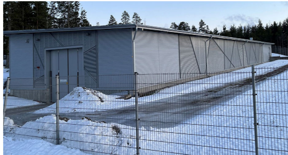
Kuva 2.11 Kehäradan ajotunnelin maanpintarakennus (Kuva: Sitowise Oy)
