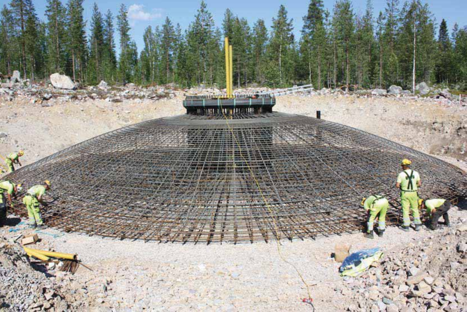
Figur 3-8. Gravitationsfundament av stålbetong, armerat före betonggjutningen, Tervola.
