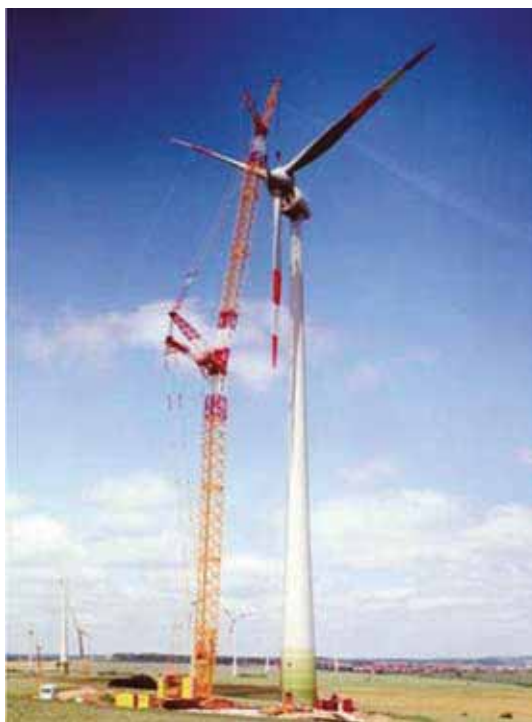
Figur 3-14. Resning av ett vindkraftverk (Taaleritehdas Oy).
