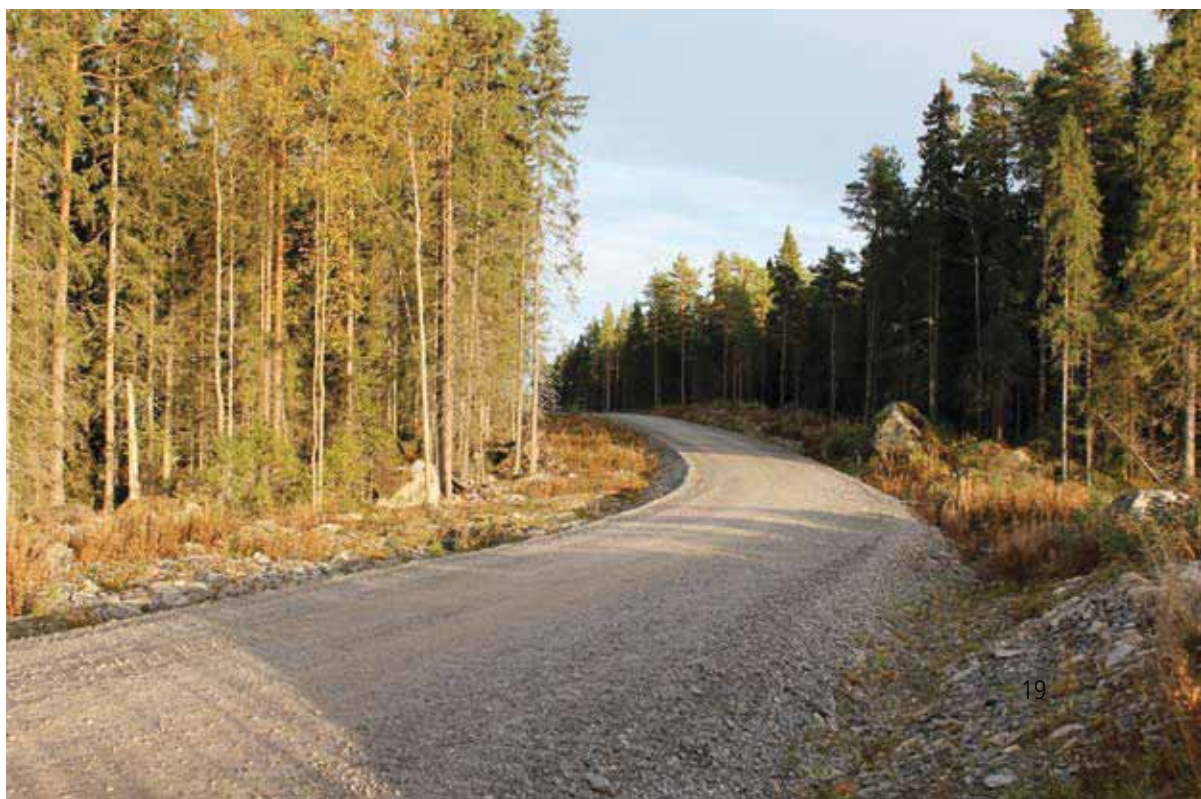
Figur 3-12. Serviceväg till ett vindkraftverk – Öjen, Vasa.
