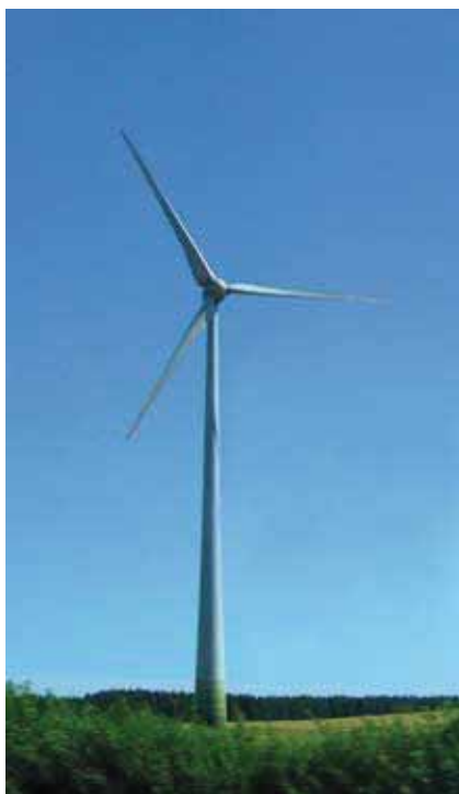
Figur 3-6. Foto av ett vindkraftverk med cylinderformad tornkonstruktion.
