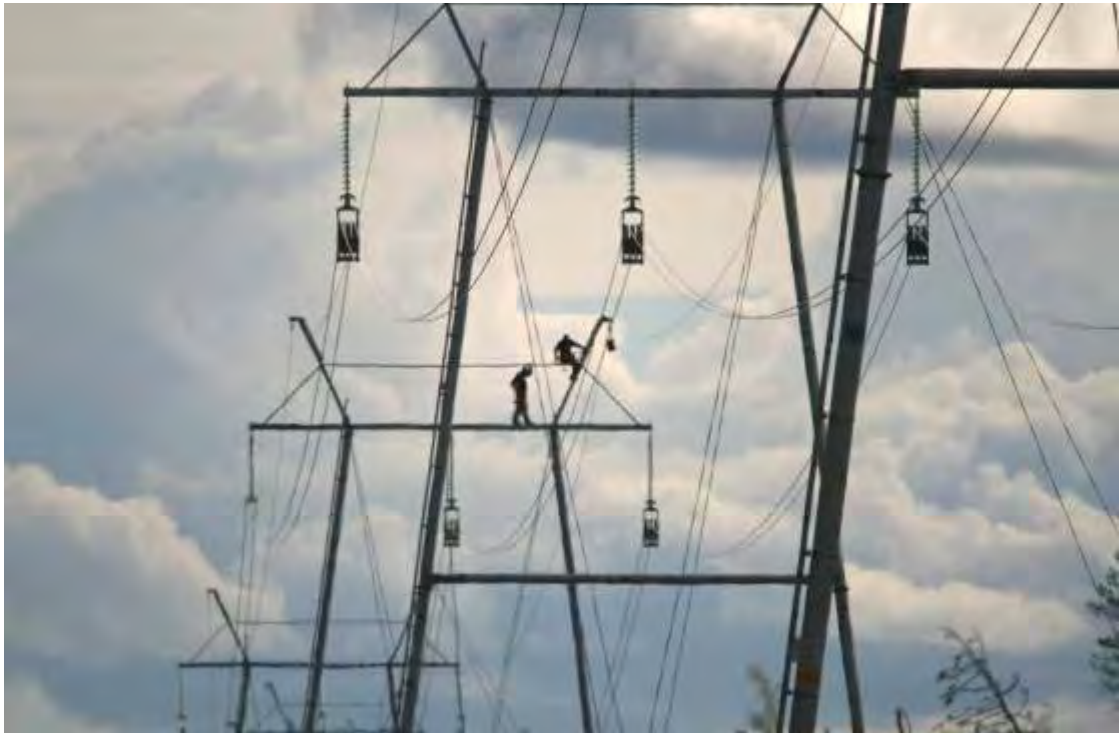
Kuva 7.1. 220 kV voimajohdon rakentamista. (Kuva: Ville Suorsa)
