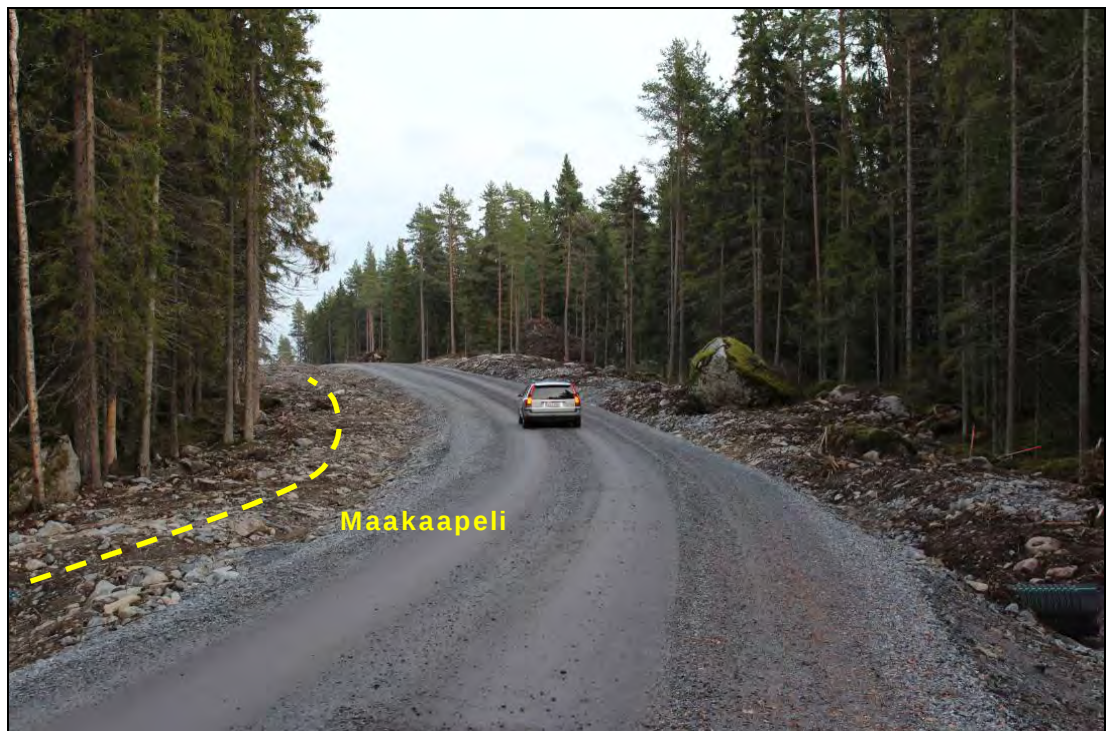
Kuva 5.6. Esimerkki tuulivoimapuiston rakennus- ja huoltotiestä. Teitä käytetään muun muassa betonin ja soran sekä voimaloiden komponenttien kuljetuksiin. Tuulivoimapuiston käyttövaiheessa teitä käytetään mm. vuosittaisissa huolloissa. Maakaapelin oja on sijoitettu tien vasemmalle puolelle. (Kuva: Hans Vadbäck / FCG)
