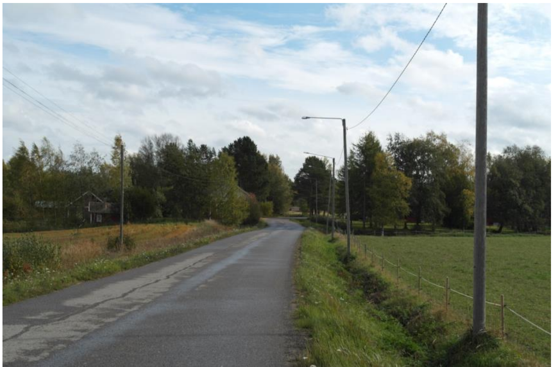
Kuva 11.13. Uttermossantie (Ellfolkin kohdalla). (Kuva: Riikka Ger / FCG).
