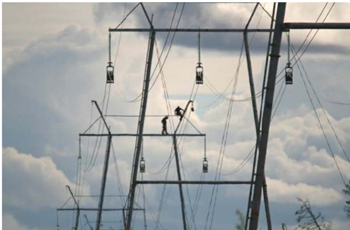
Kuva 5.12. 220 kV voimajohdon rakentamista. (Kuva: Ville Suorsa / FCG)
