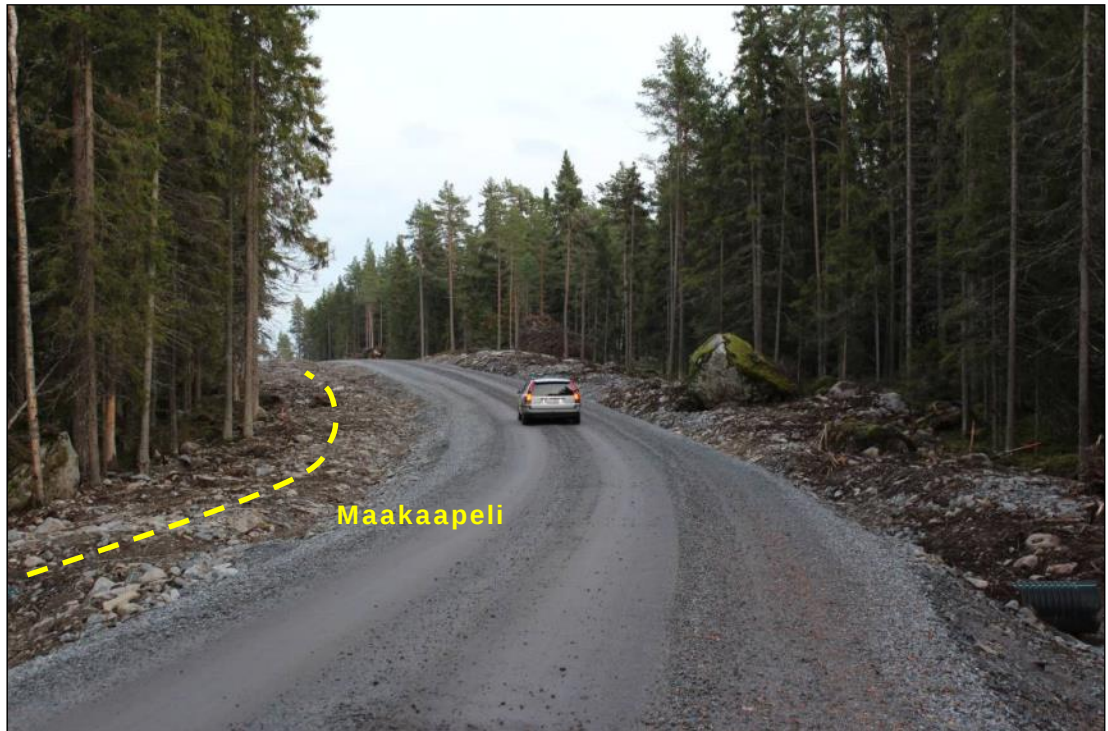
Kuva 5.6. Esimerkki tuulivoimapuiston rakennus- ja huoltotiestä. Teitä käytetään muun muassa betonin ja soran sekä voimaloiden komponenttien kuljetuksiin. Tuulivoimapuiston käyttövaiheessa teitä käytetään mm. vuosittaisissa huolloissa. Maakaapelin oja on sijaittu tien vasemmalle puolelle. (Kuva: Hans Vadbäck / FCG)
