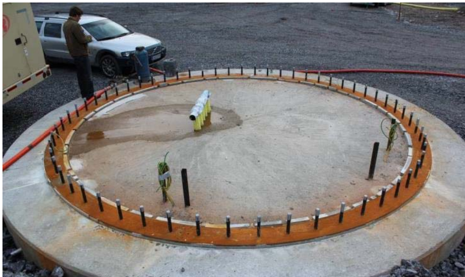
Kuva 5.5. Esimerkki tuulivoimalaitoksen perustuksesta. Perustuksen halkaisija on noin kuusi metriä. (Kuva: Hans Vadbäck / FCG)
