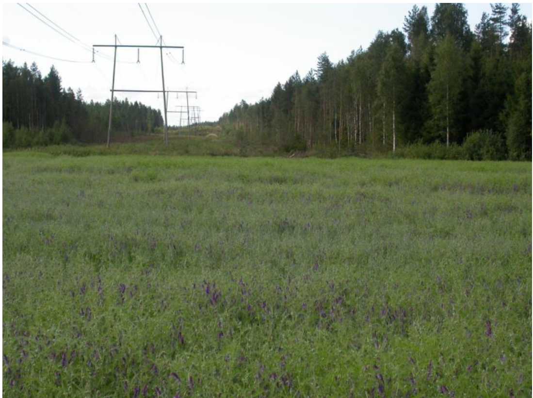
Bild 10.6. Kraftledningssträckning B sammanfaller med en befintlig linjegata som ska breddas (Korpelankylä, åker i Metsäranta). (Foto: Tiina Mäkelä/FCG)
