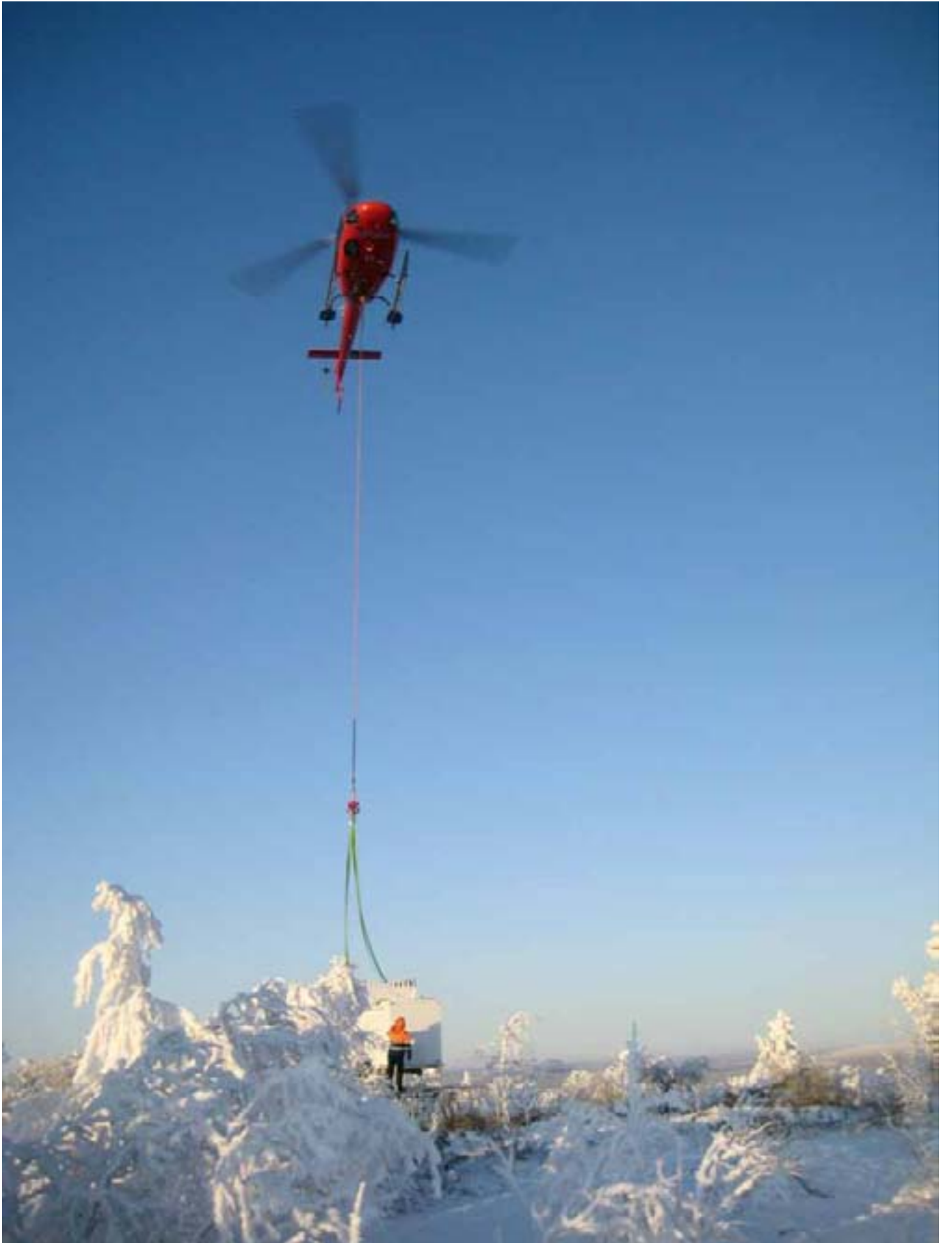
Kuva 5-1. Sodar-laitteiston asennus Mielmukavaaran huipulle. (Kuva: Jussi Sarvela)
