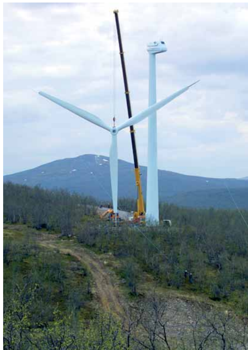
Kuva 2-8. Tuulivoimalaitoksen pystyttäminen (kuva Kirunaan pystytetystä 6 x 900 kW tuulipuistosta). Kuva: Gunnar Britse
