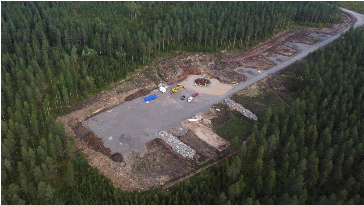
Kuva 14. Tyypillinen tuulivoimalan kokoamis- ja pystytysalue ennen voimalan pystyttämistä. (Kuva: YIT)
