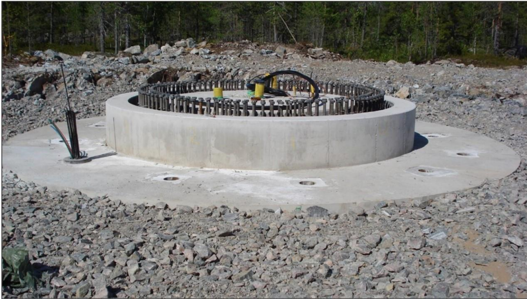
Kuva 11. Tyypillinen tuulivoimalan kallioankkuroitu teräsbetoniperustus. (Kuva: YIT)
