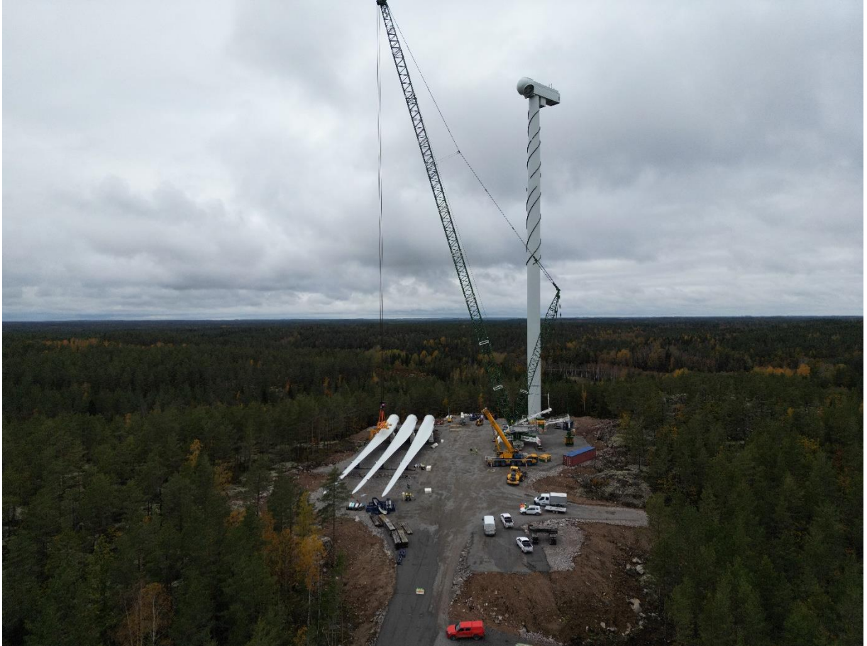
Kuva 4-2. Tuulivoimalan pystyttäminen ja maankäytön tarve (Eurowind Energy Oy).
