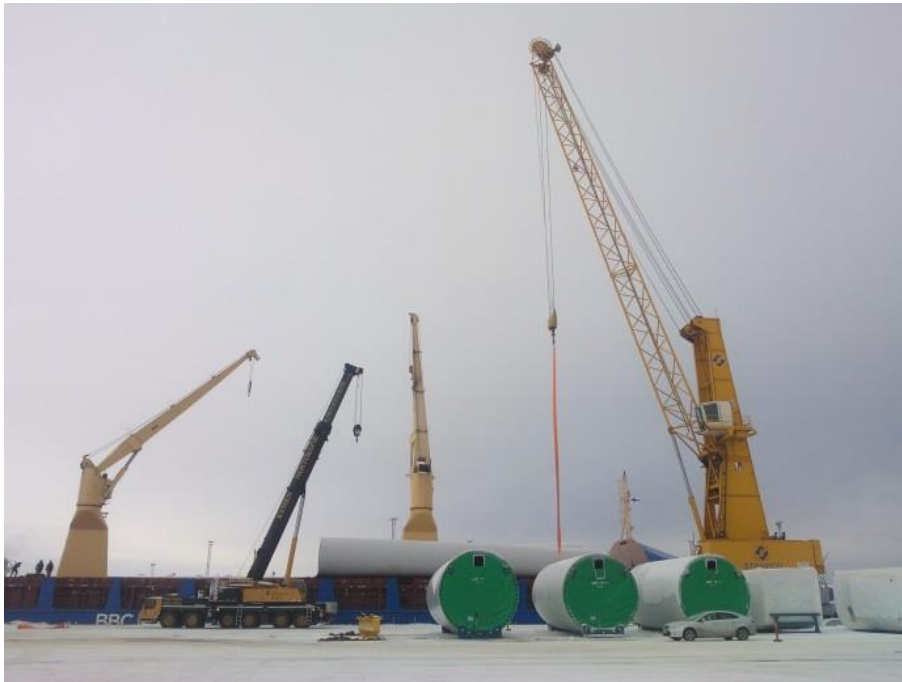
Kuva 11. Torni osissa satamassa.
