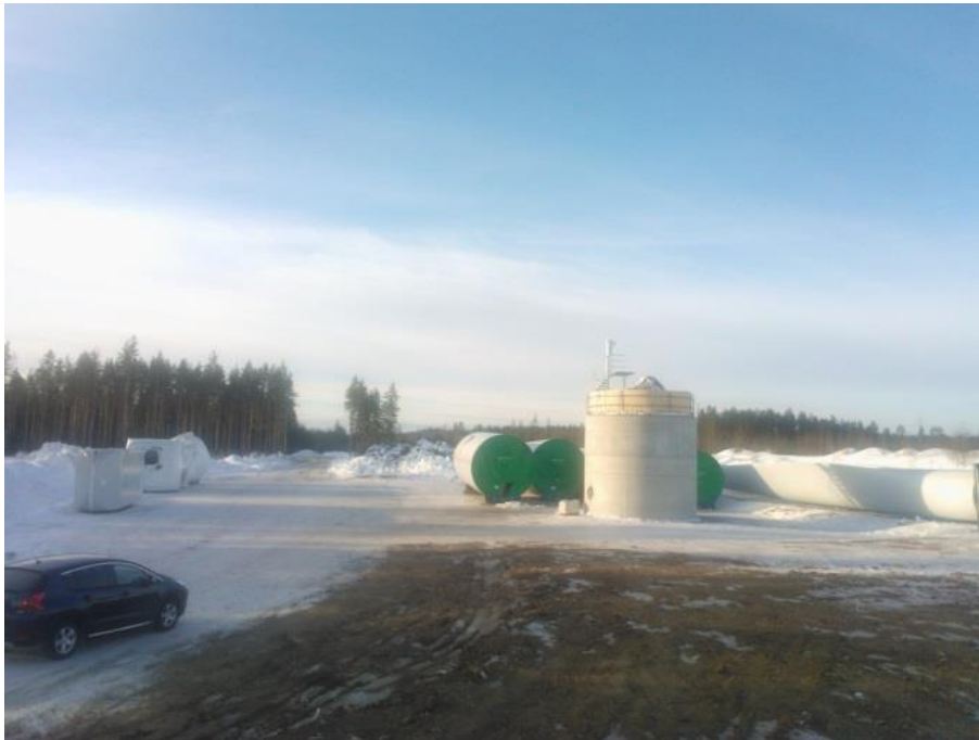
Kuva 13. Torni alkaa rakentua.
