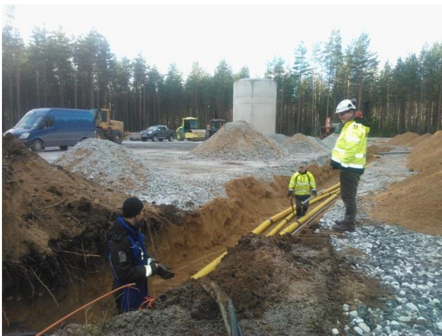
Kuva 10. Maakaapelin asennusta.
