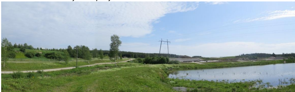
Kuva 18. Olemassa oleva voimajohtolinja ylittää jätealueen avoimet kentät sekä vesilammikon.
