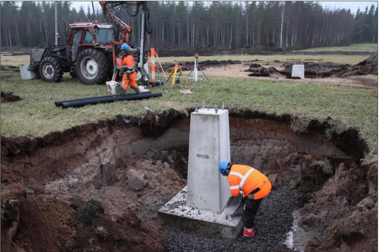
Kuva 10. Pylvään perustuselementin asentaminen.
