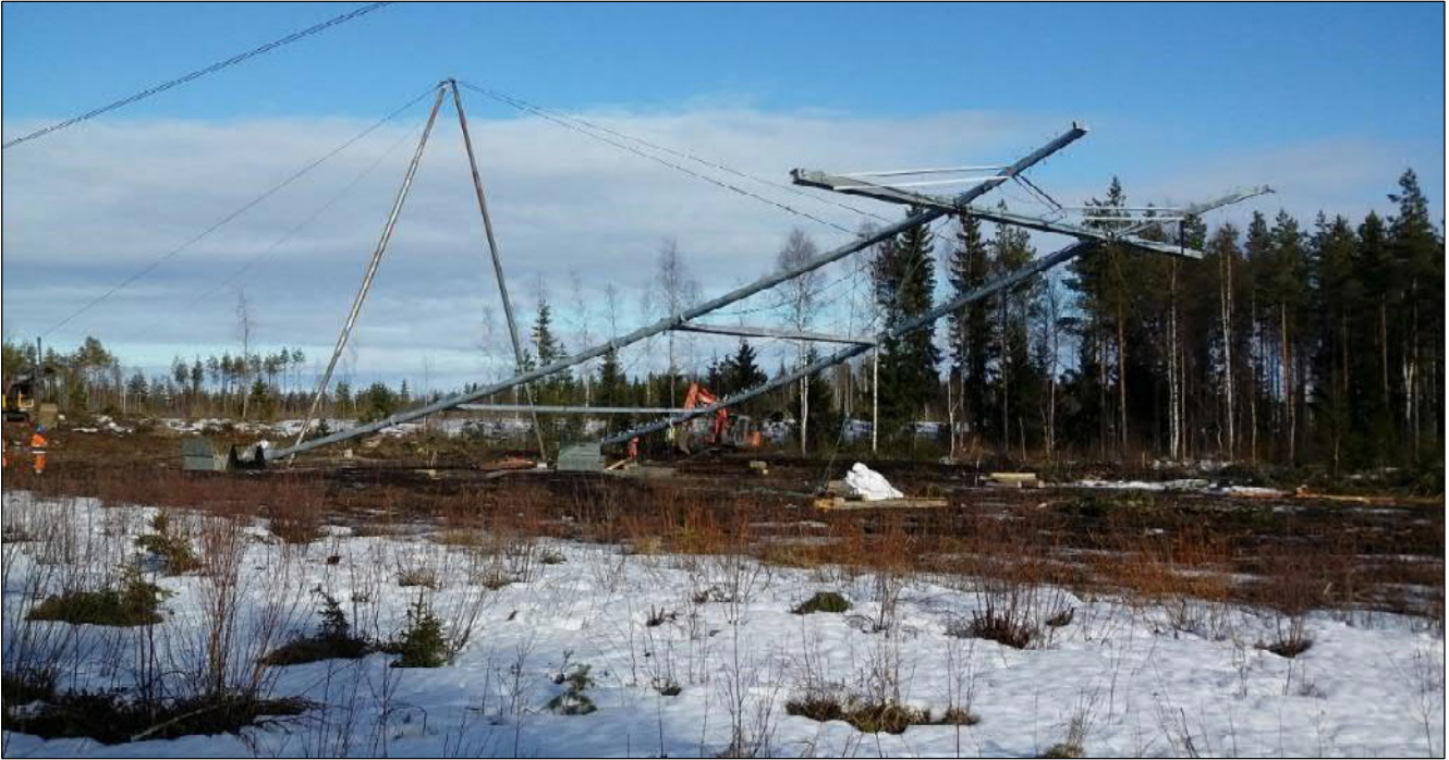
Kuva 12. Voimajohtopylvään pystytys.
