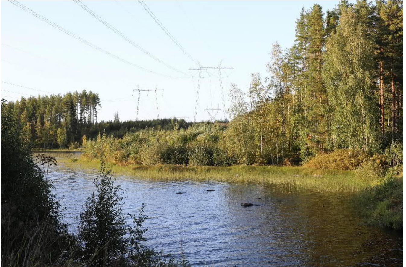
Kuva 100. Kivijärven Hannonsalmen tuntumassa sijaitseva johtokäytävä nykytilassa.
