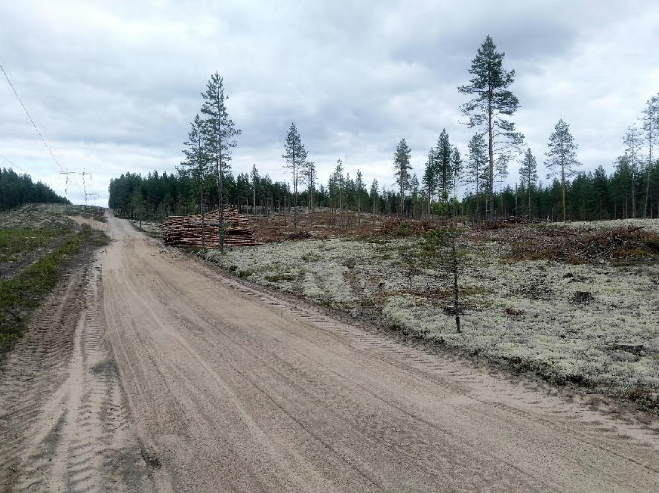
Kuva 121. Valokuva nykyiseltä johtoalueelta Rokuanvaaran eteläosasta, jossa johtoalueen reunassa on tieura. Johtoalue on kasvipeitetyksi, kun taas ajourat ovat eroosiolle alttiita.
