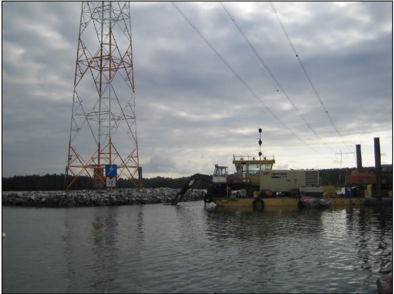
Kuva 15. Vapaasti seisovan pylvään tekoaluiskojen viimeistelyä Pyhäjärvellä Pirkkalassa.
