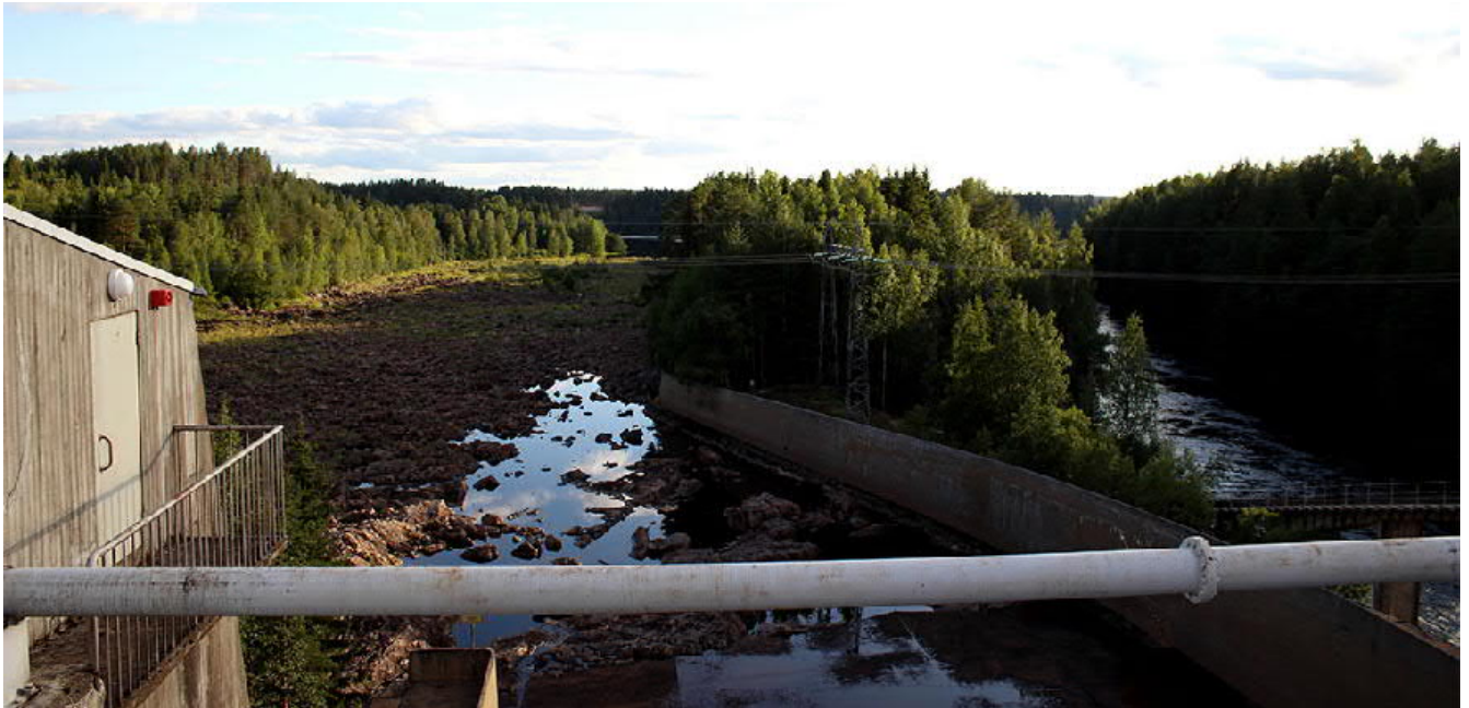
Kuva 109. Näkymä Nuojuan padon ylätasanteelta länteen päin. Nykyinen voimajohto ei ole havaittavissa maisemassa sulkeutuneiden, rantaan rajautuvien metsien takana.
