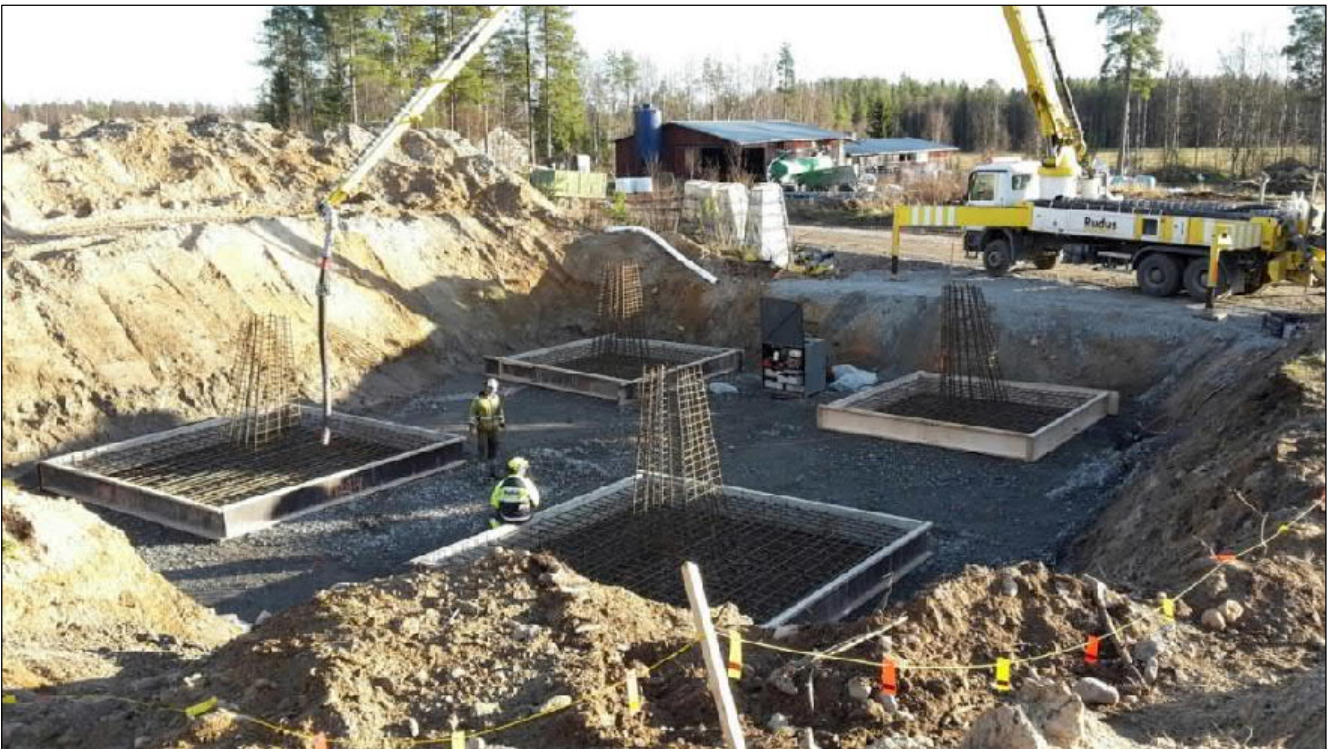
Kuva 11. Vapaasti seisovan pylvään perustuksen pohjatöitä.
