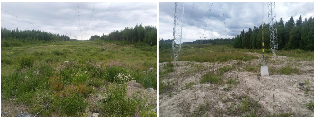
Kuva 123. Lämäkankaan kumpumoreenialueelle rakennettu Metsälinjan uusi voimajohto valmistui 2022. Rakentamisesta aiheutuneet muutokset ovat vähäisiä ja selvimmin havaittavissa pylväspaikoilla.
