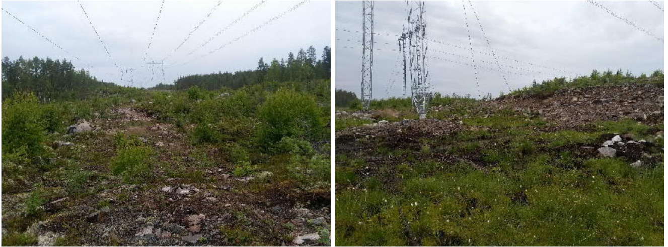
Kuva 125. Pienen Kotavaaran kumpumoreenialueella voimajohdon rakentamisesta vanhan paikalle jää jälkiä pylväspaikoille sekä ajourille. Muutokset ovat paikallisia ja ympäristö on osittain aiemmin jo häiriitynyttä.
