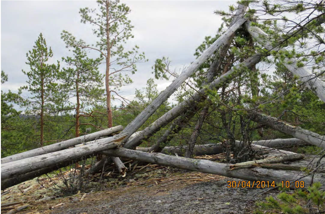
Kuva 2. Merkkikallion korkeimmalla kohdalla oleva kolmiomittaustorni on jo lahonnut ja rojahtanut maahan.
