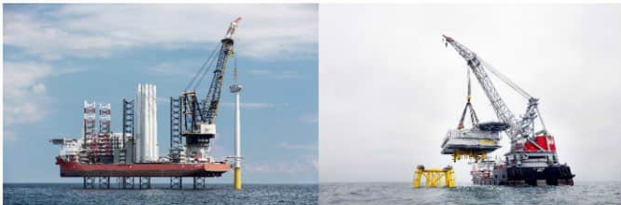
Figur 3-13. Exempel på byggande: jack-up fartyg i arbete.
