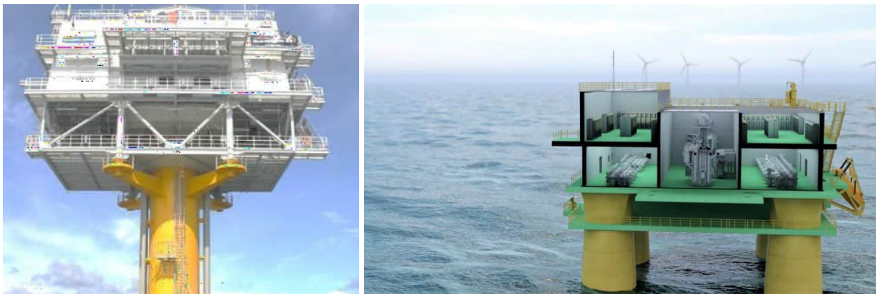
Figur 3-12. Exempel på havsbaserad elstation (Hitachi Energy).
