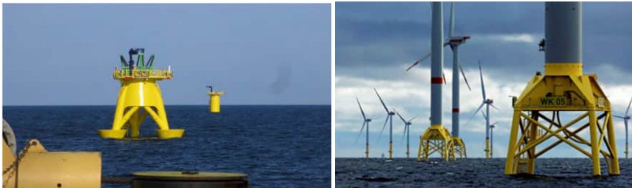
Figur 3-7. Baltic 2 och Wikinger havsfundament för isiga förhållanden.
