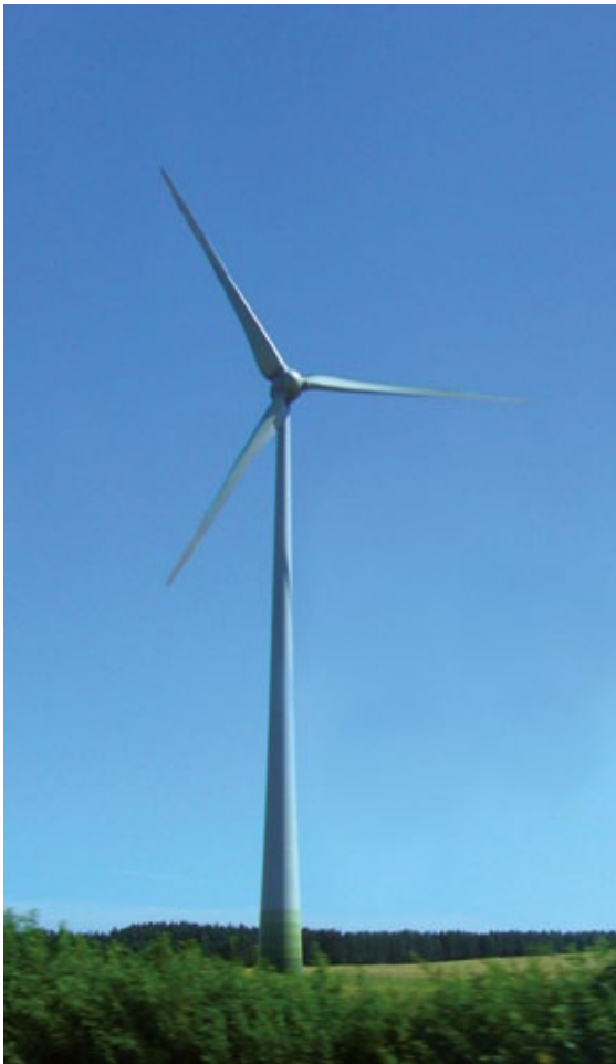
Kuva 5-3. Kuva lieriötornirakenteisesta tuulivoimalasta
