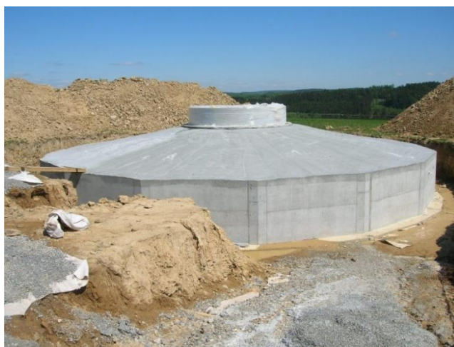
Kuva 4-4. Tuulivoimalan betonilaatta ennen sen peittämistä maa-aineksilla (kuva: Vetrna energie HL, www.vehl.cz ).
