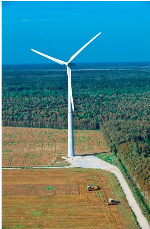
Kuva 4-5. Vasemmalla 3 MW:n tuulivoimalaitos, jonka tornin alaosa on betonia ja yläosa terästä, napakorkeus ja roottori ovat 100 m (kuva: WinWinD). Oikealla on periaatekuva tuulivoimalasta (kuva: planete-energies.com).
