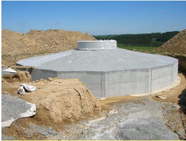
Kuva 4-6. Tuulivoimalan betonilaatta ennen sen peittämistä maa-aineksilla (kuva: Vetrna energie HL, www.vehl.cz ).
