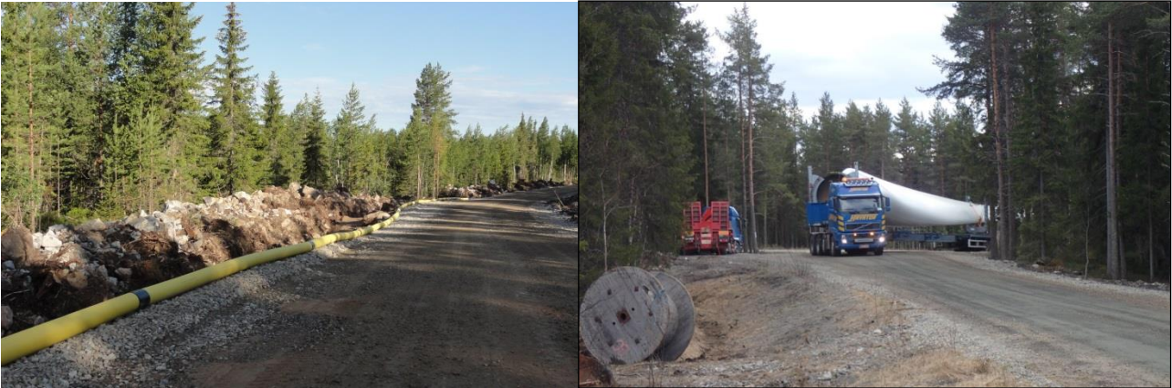
Kuva 5.7. (Vasemmalla) Esimerkki tuulivoimapuiston rakennus- ja huoltotiestä. Teitä käytetään muun muassa betonin, soran ja voimaloiden komponenttien kuljetuksiin sekä tuulivoimapuiston käyttövaiheessa huoltoajoihin. Maakaapeli sijoitetaan ojakaivantoon tien reuna-alueelle. (Oikealla) Tuulivoimalan osia kuljetetaan erikoiskuljetuksina. (Kuvat: Ville Suorsa / FCG).
