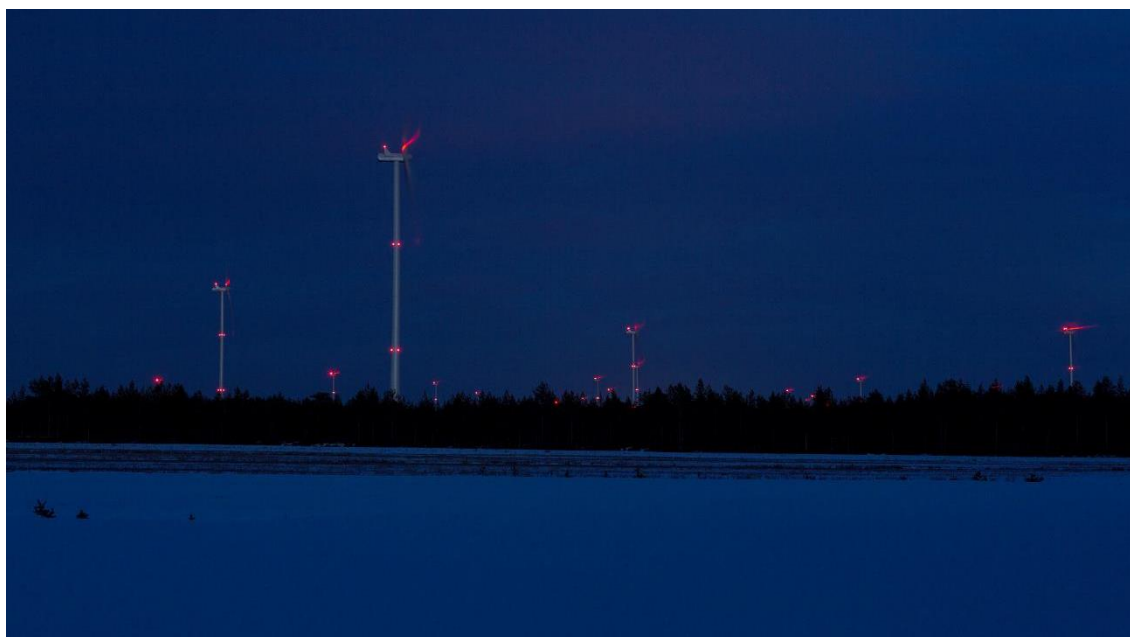
Kuva 5.5. Kiinteät punaiset lentoestevalot. (Kuva: Ville Suorsa, FCG)
