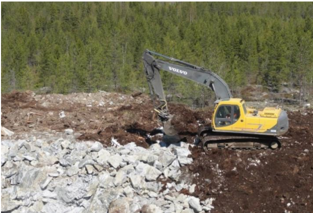
Kuvapari 5.9. Tuulivoimapuiston rakentaminen alkaa huoltoteiden ja pystytysalueiden rakentamisella (kuvat: Ville Suorsa, FCG).
