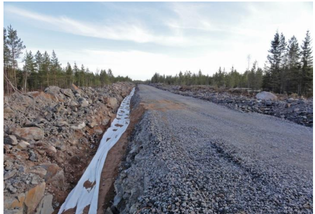
Kuvapari 5.10. Maakaapelit upotetaan huoltoteiden yhteyteen (kuvat: Ville Suorsa/FCG).
