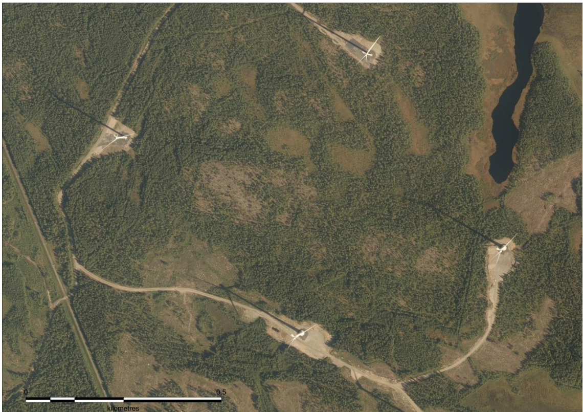
Kuva 5.1. Esimerkki-ilmakuvassa näkyy toiminnassa olevia tuulivoimaloita. Tuulivoimaloita varten on rakennettu huoltotiet ja nostokentät. Tuulivoimaloiden ympäristössä ja välialueilla aikaisempi maankäyttö on säilynyt ennallaan.
