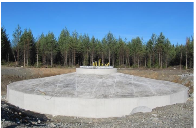
Kuvapari 5.11. Tuulivoimalan perustusten rakentamista. (Kuvat: Leila Väyrynen, FCG)
