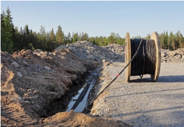
Kuvapari 5.10. Maakaapelit upotetaan huoltoteiden yhteyteen (kuvat: Ville Suorsa/FCG).
