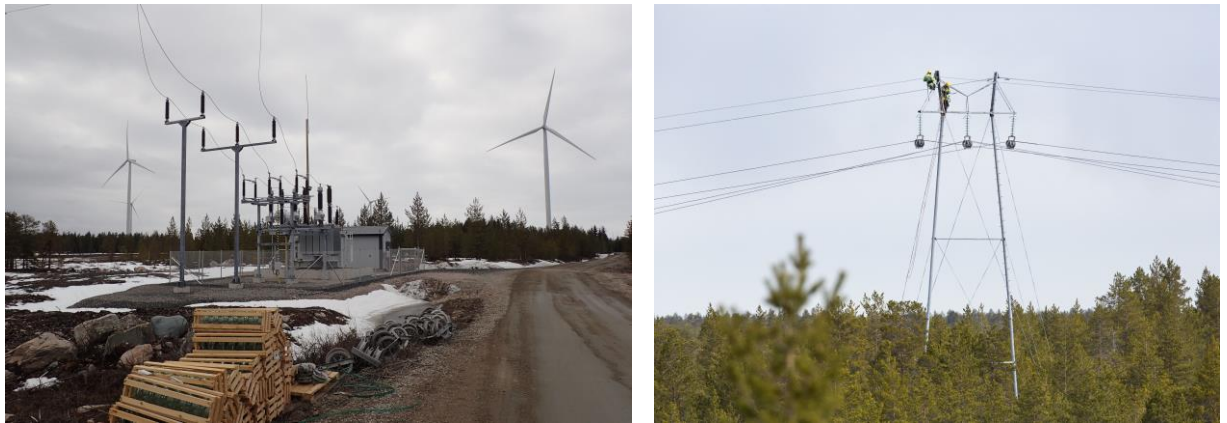
Kuvapari 5.14. Sähköaseman ja voimajohdon rakentamista. (Kuvat: Ville Suorsa, FCG)
