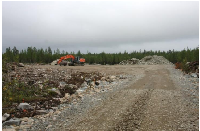
Kuvapari 5.9. Tuulivoimapuiston rakentaminen alkaa huoltoteiden ja pystytysalueiden rakentamisella (kuvat: Ville Suorsa, FCG).
