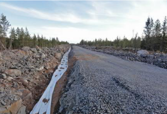
Kuvapari 4.13. Maakaapelit upotetaan huoltoteiden yhteyteen (kuvat: FCG).
