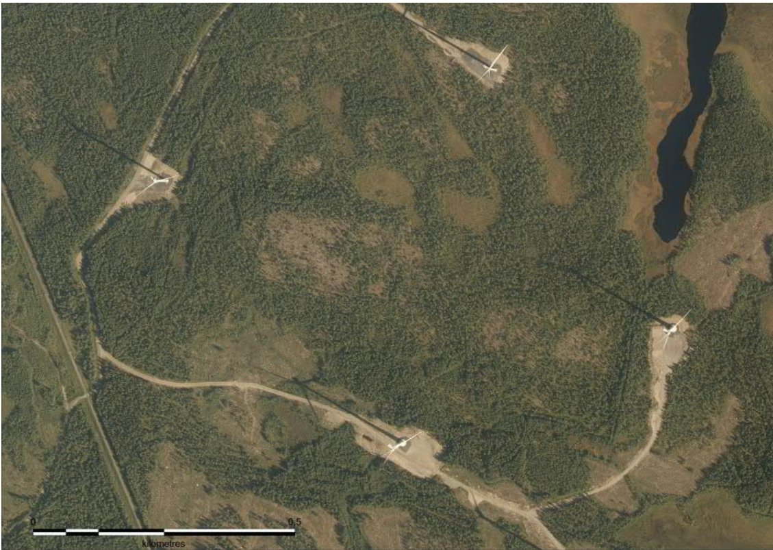
Kuva 4.1. Esimerkki-ilmakuvassa näkyy toiminnassa olevia tuulivoimaloita. Tuulivoimaloita varten on rakennettu huoltotiet ja nostokentät. Tuulivoimaloiden ympäristössä ja välialueilla maankäyttö on säilynyt ennallaan.
