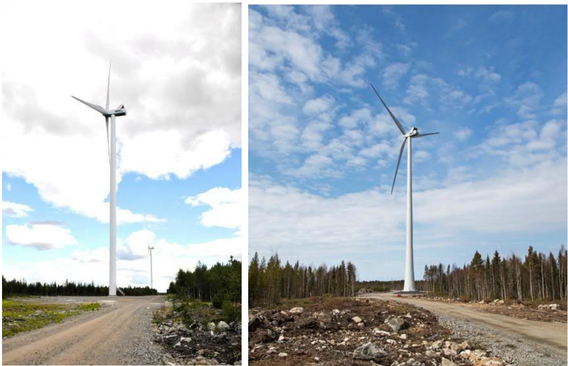
Kuva 4.2. Vasemmalla on esimerkki teräslieriötornista ja oikealla hybriditornista. (Kuvat: FCG)
