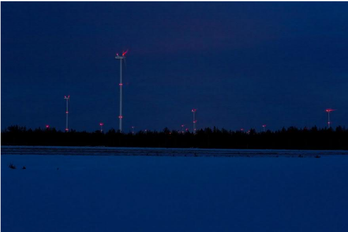
Kuva 4.5. Kiinteät punaiset lentoestevalot. (Kuva: Ville Suorsa, FCG)
