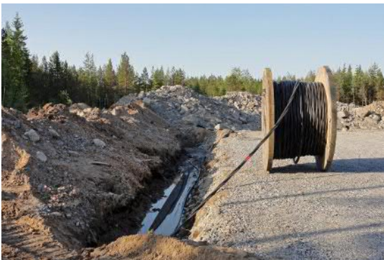
Kuvapari 4.13. Maakaapelit upotetaan huoltoteiden yhteyteen (kuvat: FCG).
