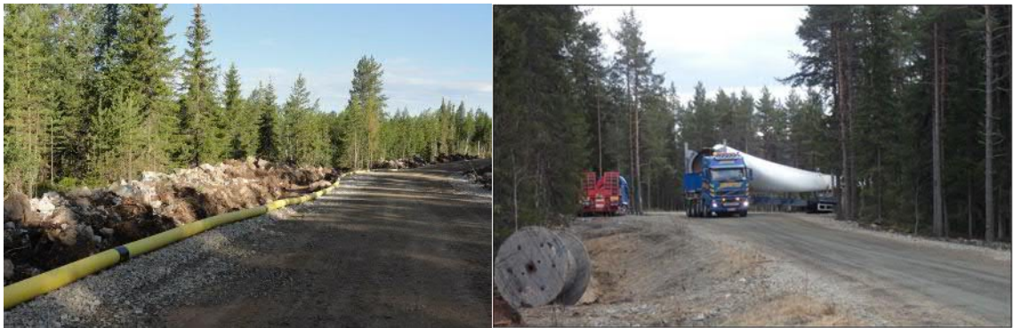
Kuva 4.8. (Vasemmalla) Esimerkki tuulivoimapuiston rakennus- ja huoltotiestä. Teitä käytetään muun muassa betonin, soran ja voimaloiden komponenttien kuljetuksiin sekä tuulivoimapuiston käyttövaiheessa huoltoajoihin. Maakaapeli sijoitetaan ojakaivantoon tien reuna-alueelle. (Oikealla) Tuulivoimalan osia kuljetetaan erikoiskuljetuksina. (Kuvat: FCG).
