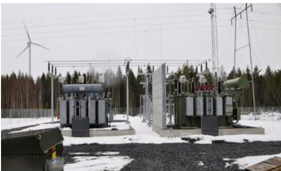
Kuvapari 4.15. Esimerkkikuvia tuulivoimapuiston 110/20 kV sähköasemasta. (Kuvat: Leila Väyrynen/FCG).
