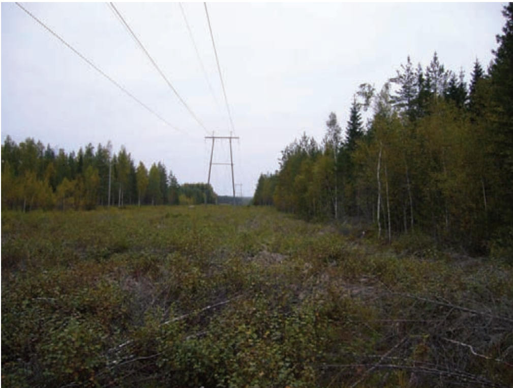
Kuva 24. Voimalinja sivuaa rakennuspaikkaa 11.
