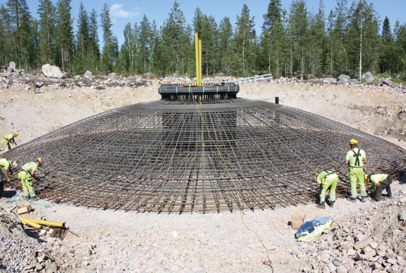
Kuva 3-8. Maanvarainen teräsbetoniperustus raudoitettuna ennen betonivalua, Tervola.
