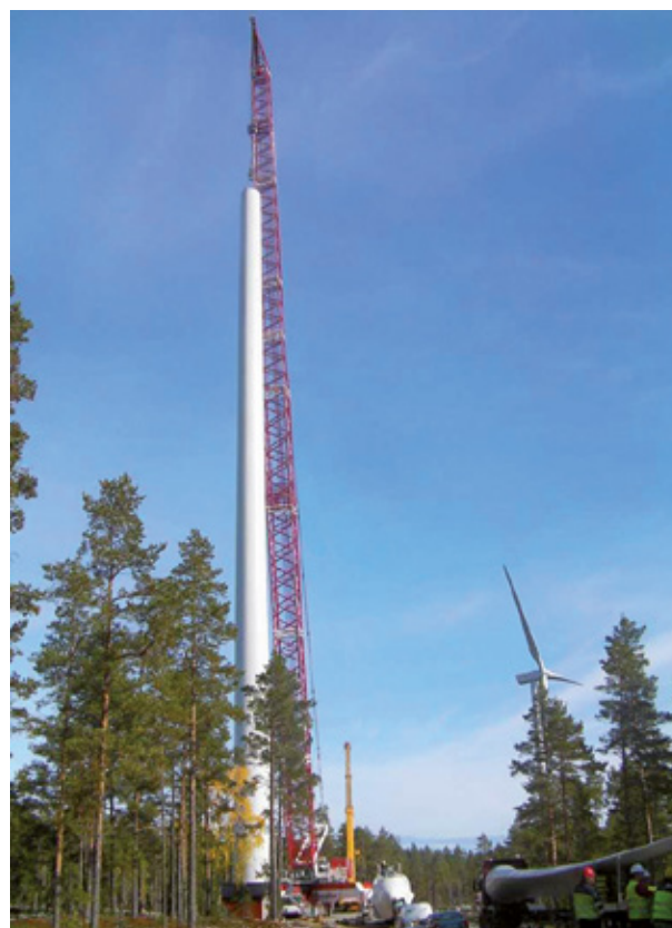
Kuva 3-22. Tuulivoimalan pystytys (Nordisk Vindkraft Oy).
