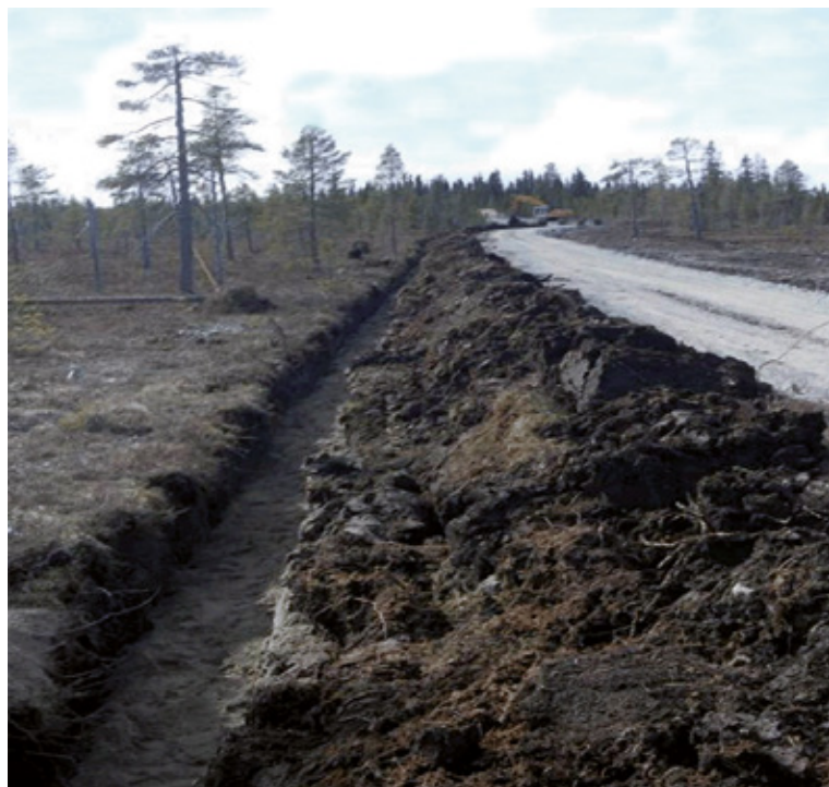
Kuva 3-14. Maakaapelit sijoitetaan ensisijaisesti huoltoteiden yhteyteen (Nordisk Vindkraft Oy).
