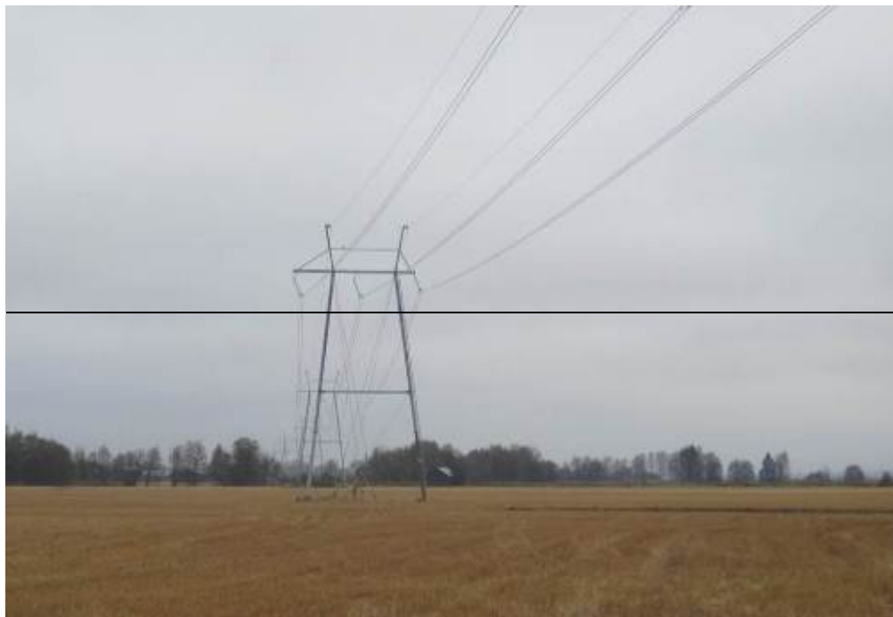
Figur 13. Exempel på en 110 kV luftledning med stagade portalstolpar.
