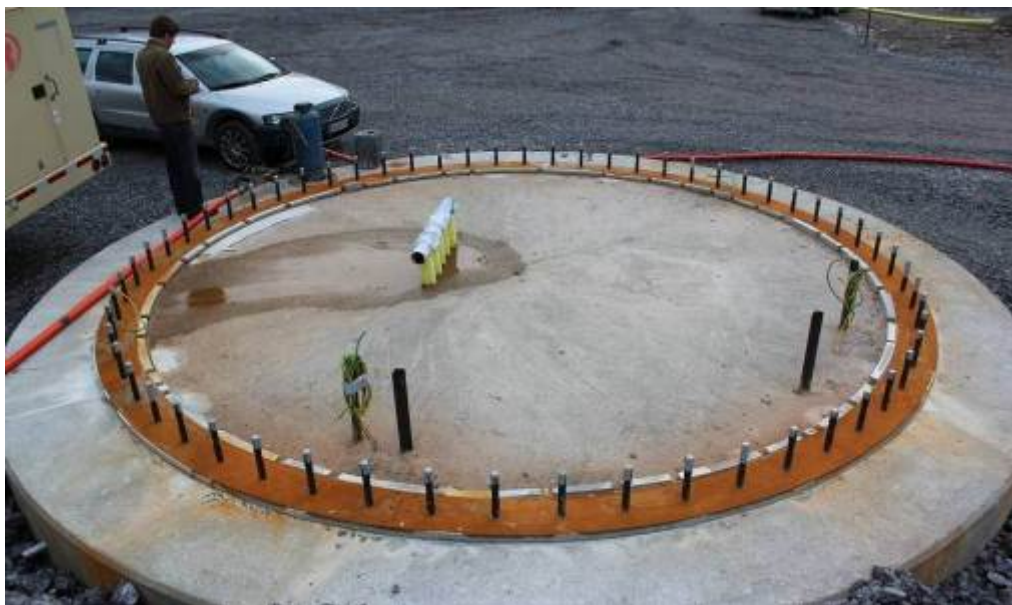
Figur 7. Exempel på vindkraftverks fundament i vilken diametern är cirka 6 meter.
