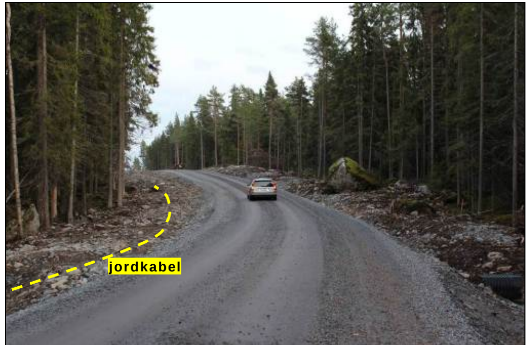
Figur 11. Exempel på privat väg för transport av vindkraftverk och placeringen av elöverföringskabeln i samma linje med vägen.
