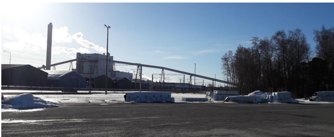
Figur 7-3. Utsikt från porten till Alholmens såg i riktning mot söder. På bilden finns Alholmens Krafts bandtransportör samt järnväg. Den röda pilen i Figur 7-2 visar stället där fotot har tagits och i vilken riktning. (Foto: Elin Siggberg)
