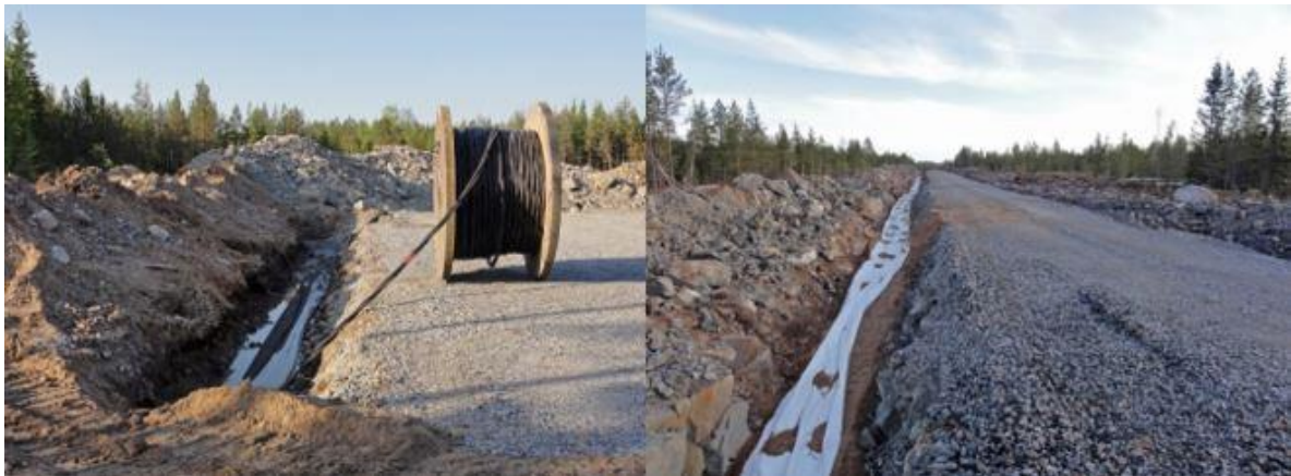
Bild 5.12 Jordkablarna grävs ner i anslutning till servicevägarna (FCG).
