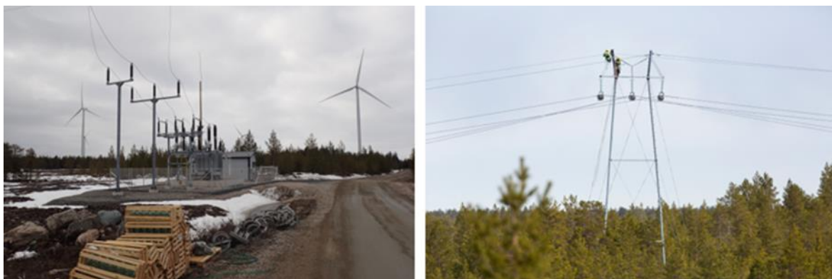
Bild 5.16 Byggande av elstationen och kraftledningen (bilder: FCG).
