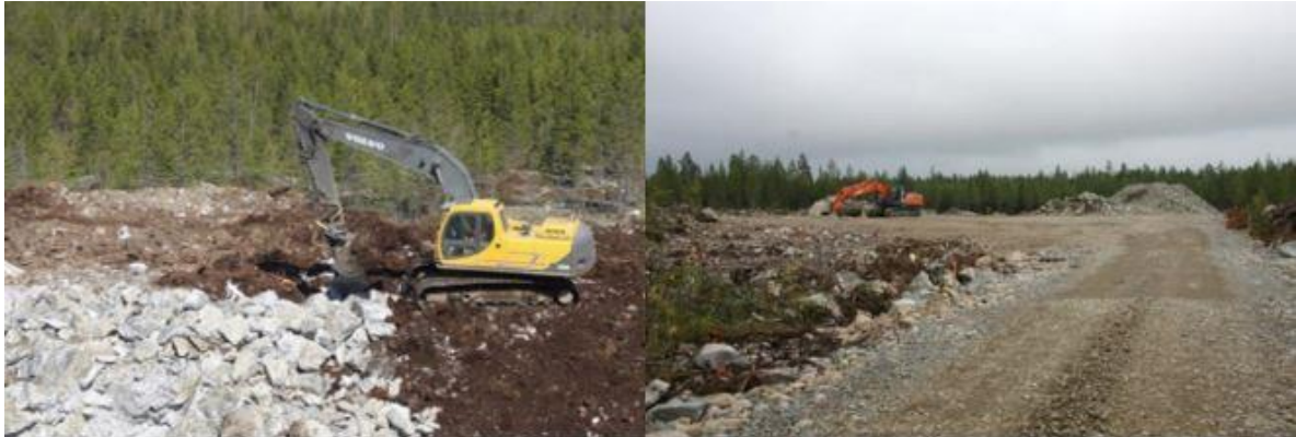
Bild 5.11 Byggandet av vindkraftsparken inleds med att bygga vägar och service-/resningsområden (FCG).
