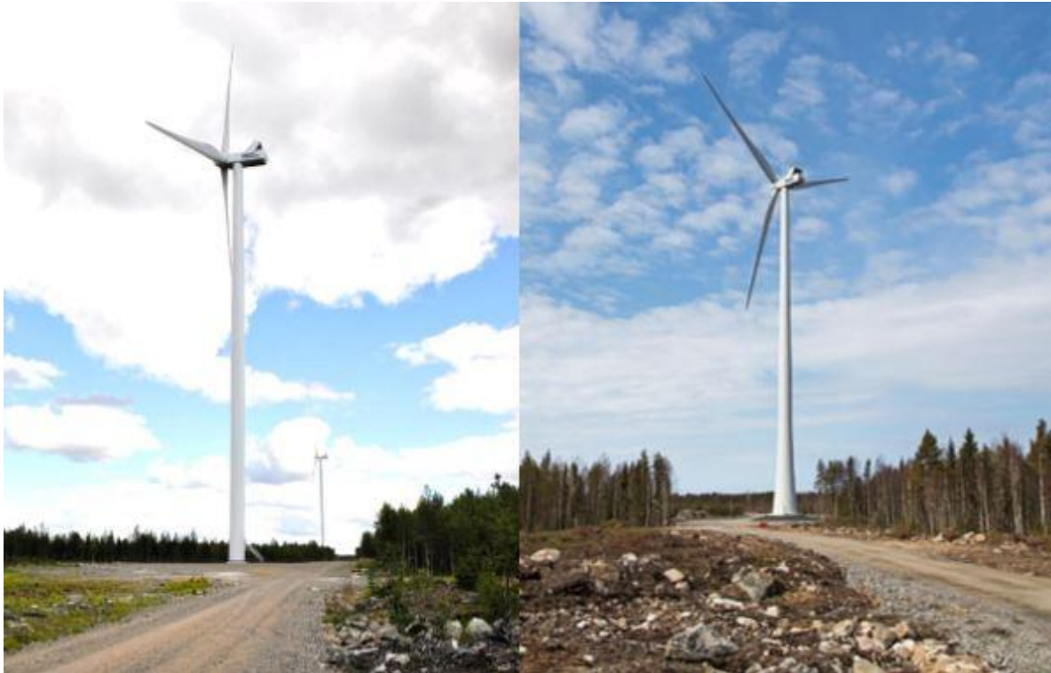
Bild 5.2 Till vänster ett exempel på ett stålcylindertorn och till höger ett hybridtorn (FCG).
