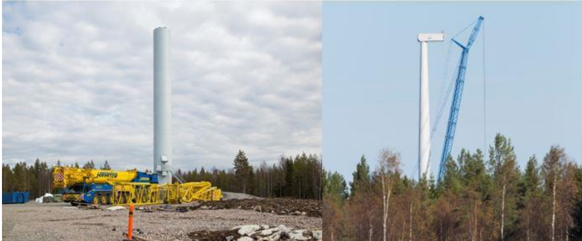
Bild 5.14 Montering av vindkraftverk (FCG).
