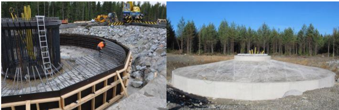
Bild 5.13 Byggande av vindkraftverkens fundament (FCG).
