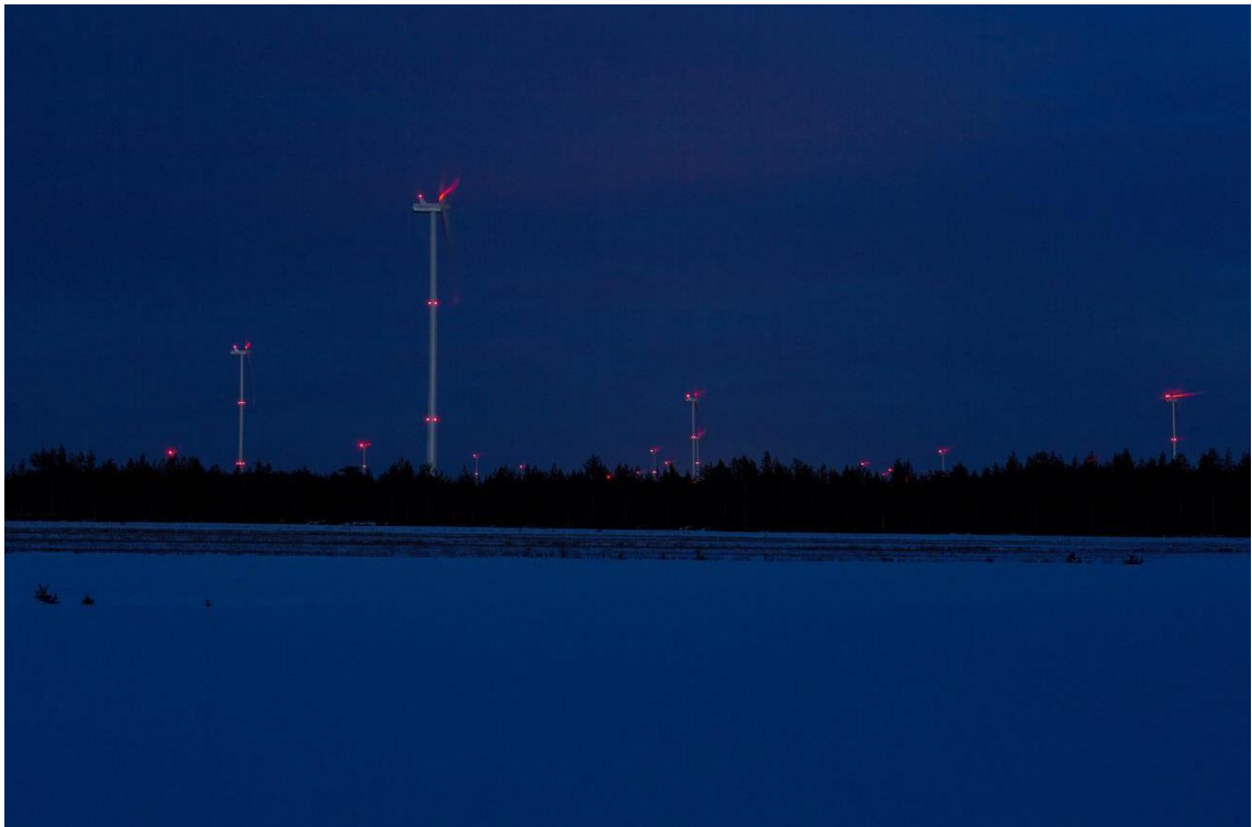
Kuva 5.4. Kiinteät punaiset lentoestevalot. (Kuva: Ville Suorsa, FCG)
