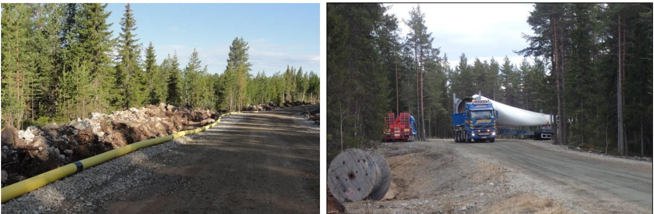
Kuva 5.6. (Vasemmalla) Esimerkki tuulivoimapuiston rakennus- ja huoltotiestä. Teitä käytetään muun muassa betonin, soran ja voimaloiden komponenttien kuljetuksiin sekä tuulivoi- mapuiston käyttövaiheessa huoltoajoihin. Maakaapeli sijoitetaan ojakaivantojen tien reuna-alueelle. (Oikealla) Tuulivoimalan osia kuljetetaan erikoiskuljetuksina. (Kuvat: Ville Suorsa / FCG).
