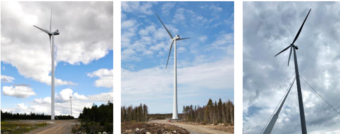
Kuva 5.2. Vasemmalla on esimerkki teräslieriötornista, keskellä hybriditornista ja oikealla harustetusta tornista. (Kuvat: Leila Väyrynen ja Ville Suorsa, FCG sekä Jarkko Finnilä, Carelin)
