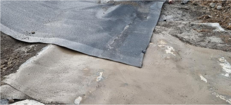
Kuva 18. Suojakalvo limitettiin erotusrakenteen (2019 rakennettu) kalvon päälle. ”
