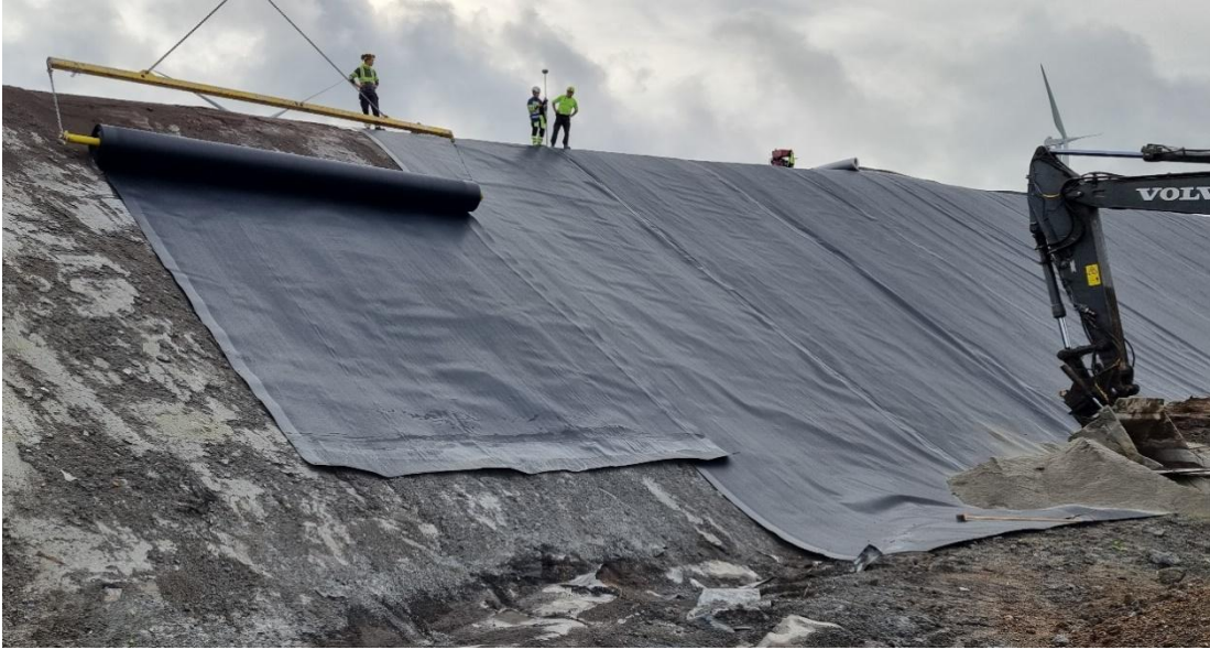
Kuva 17. Fortumin ja Erityisjätteen Suojakalvon levitys.
