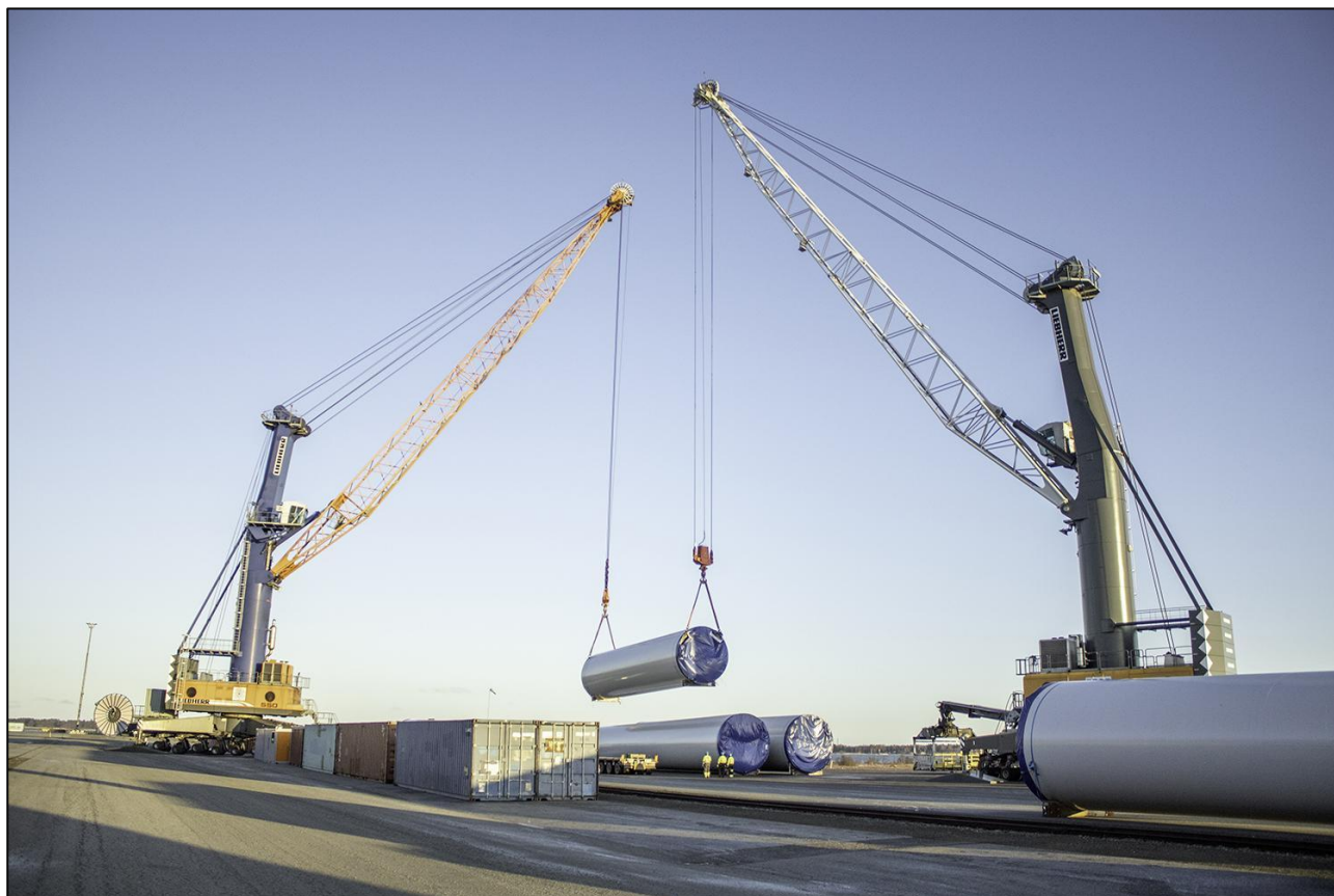
Kuva 7. Tuulivoimatornin kokoamista Porin satamassa (kuva: Porin Satama)
