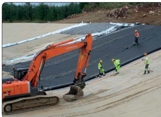
Kuva 4-10 Koboltti-nikkelirikasteen varastoaltaan pohjarakenteen valmistamista (kuva Petri Ronkainen).
