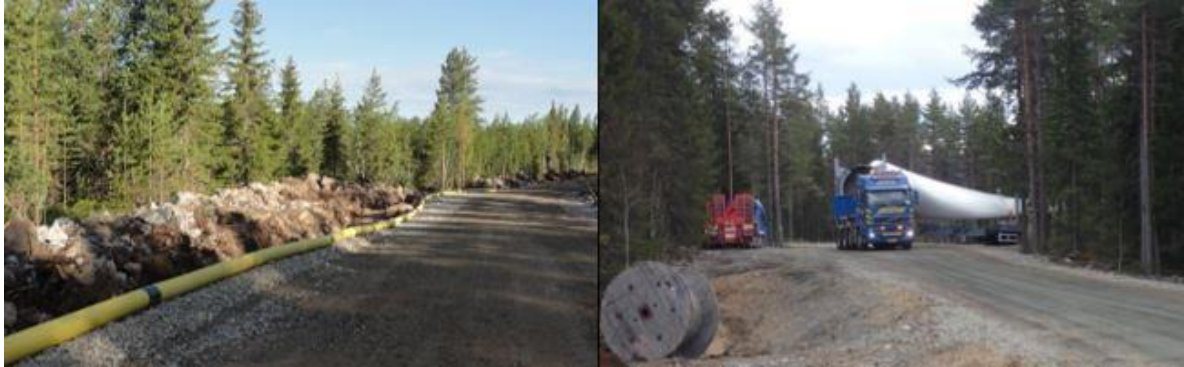
Kuva 5-6 Vasemmalla esimerkkinä rakentamisvaiheessa otettu kuva tuulivoimapuiston rakennus- ja huoltotiestä. Oikealla tuulivoimalan osia kuljetetaan erikoiskuljetuksina (FCG).
