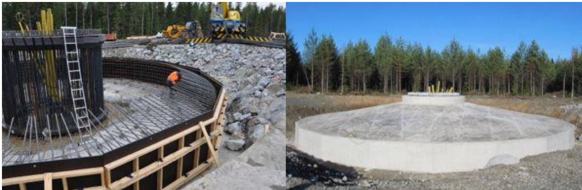
Kuva 5-13 Tuulivoimalan perustusten rakentamista (FCG).
