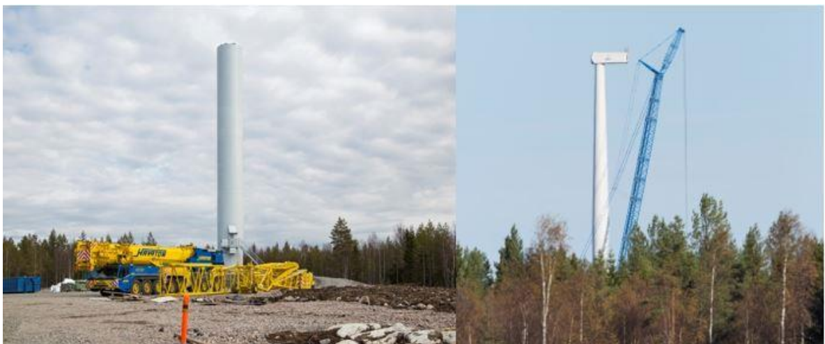
Kuva 5-14 Tuulivoimalan kokoamista (FCG).
