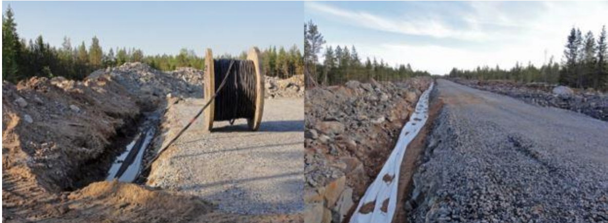
Kuva 5-12 Maakaapelit upotetaan huoltoteiden yhteyteen (FCG).
