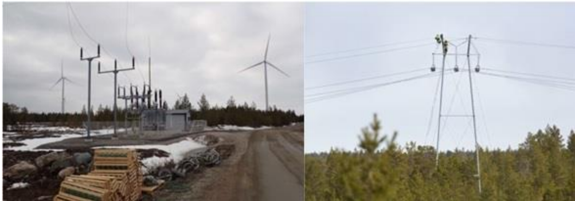
Kuva 5-16 Sähkösäntan ja voimajohdon rakentamista (FCG).
