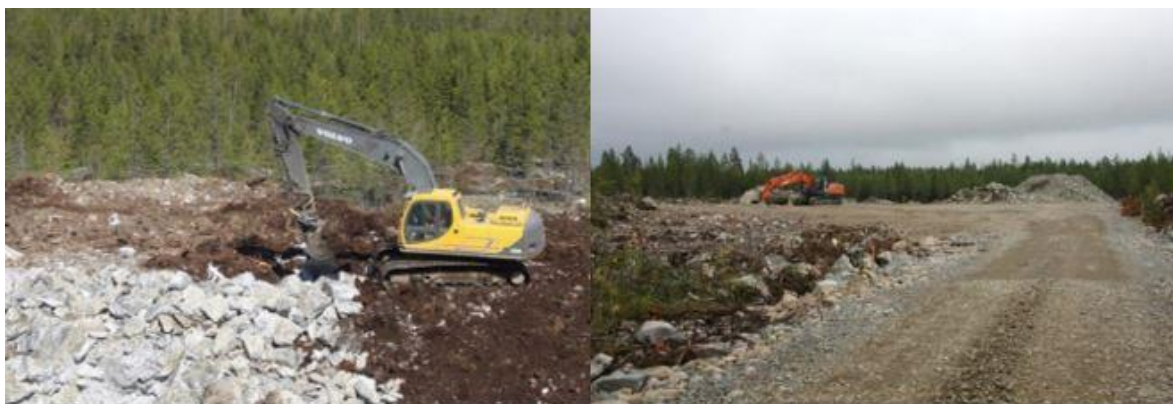
Kuva 5-11 Tuulivoimapuiston rakentaminen alkaa huoltoteiden ja pystytysalueiden rakentamisella (FCG).
