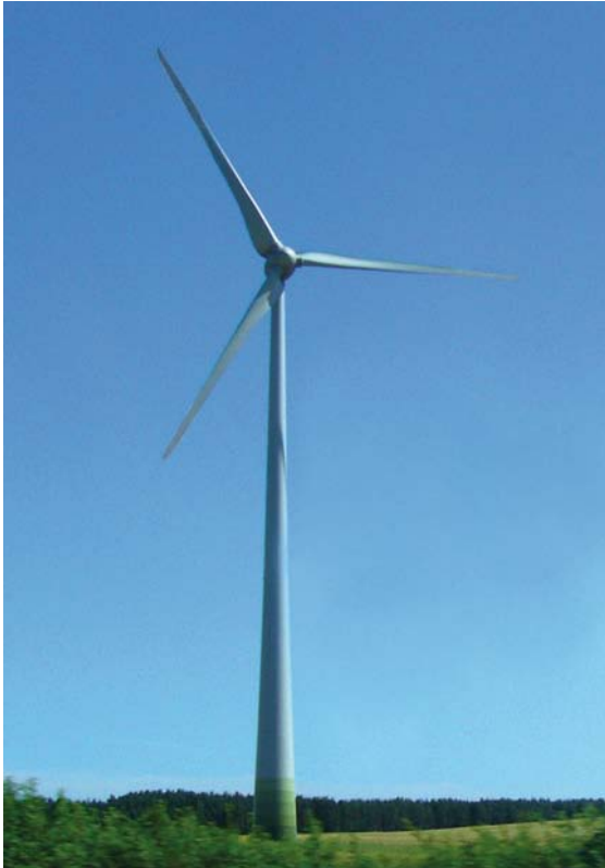
Kuva 3-2. Kuva lieriötornirakenteisesta tuulivoimalasta.
