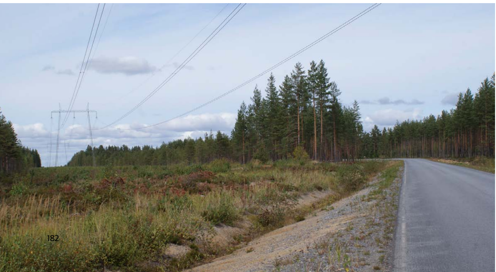
Kuva 16-16. Näkymä pohjoiseen Niskakankaantien ja nykyisen 400 kV voimajohdon leikkauskohdassa.
