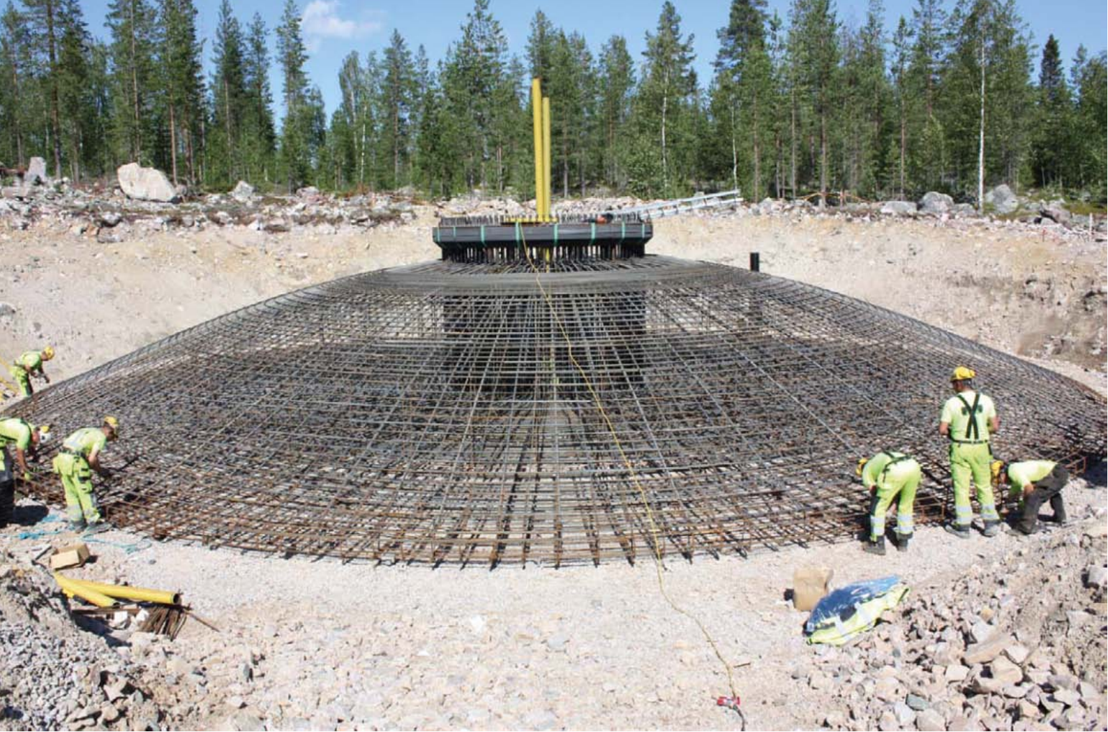
Kuva 3-8. Maanvarainen teräsbetoniperustus raudoitettuna ennen betonivalua, Tervola (Ramboll Finland Oy 2013).
