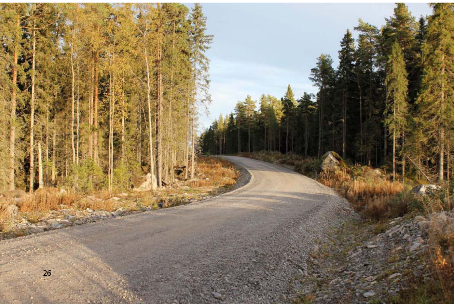
Kuva 3-12. Tuulivoimalan huoltotie - Öjen, Vaasa (Ramboll Finland Oy).
