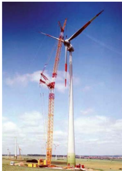
Kuva 3-17. Tuulivoimalan pystytys (Liebherr).
