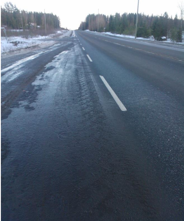
Kuva 12. VT 18 ja Louhikonmäentien risteysalue kuvattuna Seinäjoelle päin (Thermopolis Oy).
