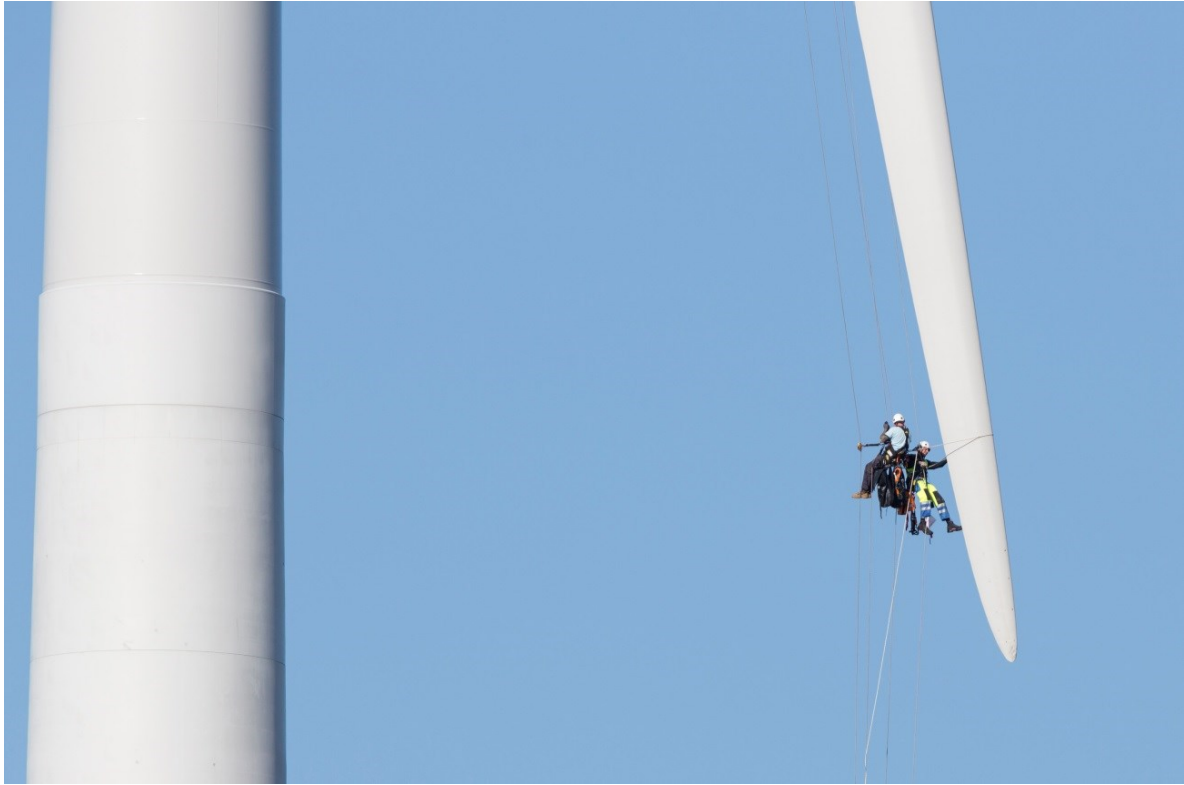
Kuva 5-16 Tuulivoimalan huoltotoimenpiteitä (FCG Finnish Consulting Group Oy).
