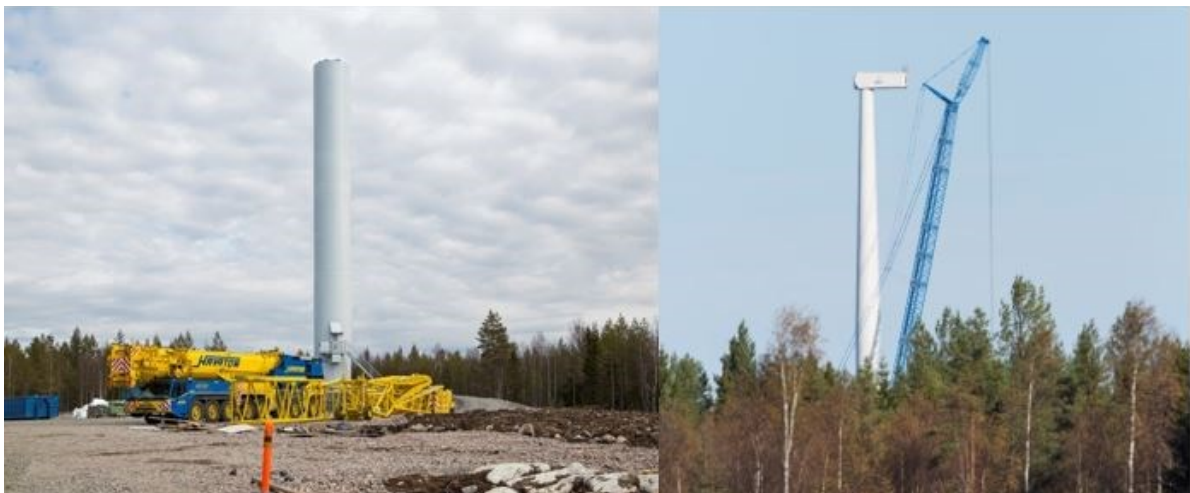
Kuva 5-13 Tuulivoimalan kokoamista (FCG Finnish Consulting Group Oy).
