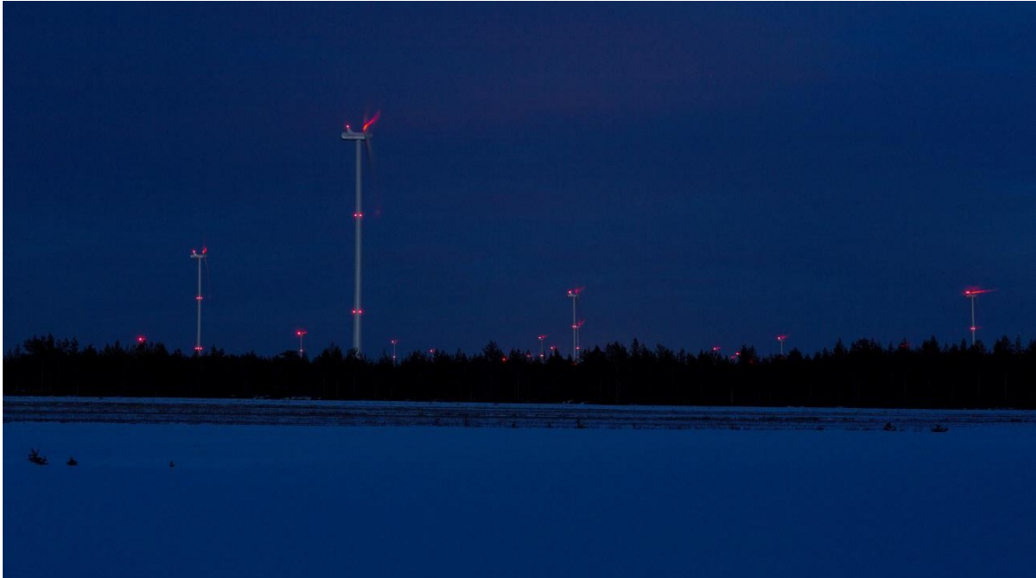
Kuva 5-4 Kiinteät punaiset lentoestevalot (FCG Rakennettu Ympäristö Oy).
