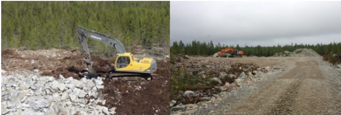
Kuva 5-10 Tuulivoima-alueen rakentaminen alkaa huoltoteiden ja pystytysalueiden rakentamisella (FCG Finnish Consulting Group Oy).
