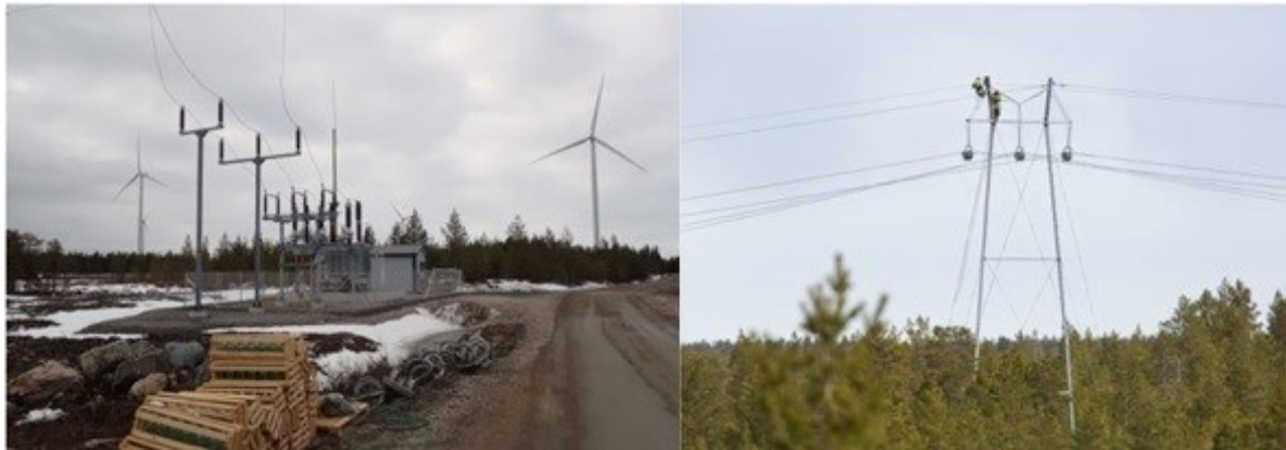
Kuva 5-15 Sähköaseman ja voimajohdon rakentamista (FCG Finnish Consulting Group Oy).
