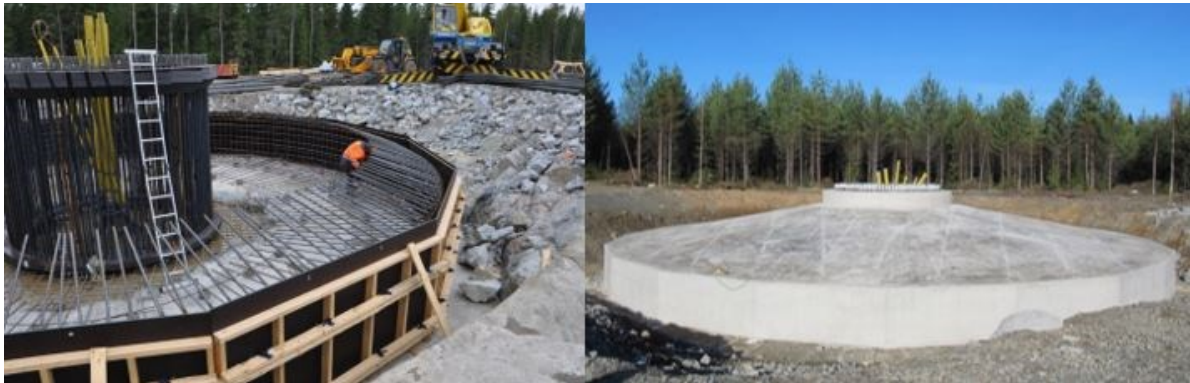
Kuva 5-12 Tuulivoimalan perustusten rakentamista (FCG Finnish Consulting Group Oy).
