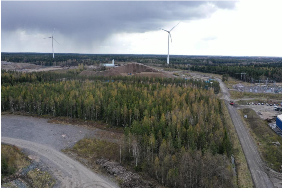
Kuva 4-10. Dronekuva pohjoisemmasta laajennusalueesta (kuvio 7) pohjoisesta etelään kuvattuna.
