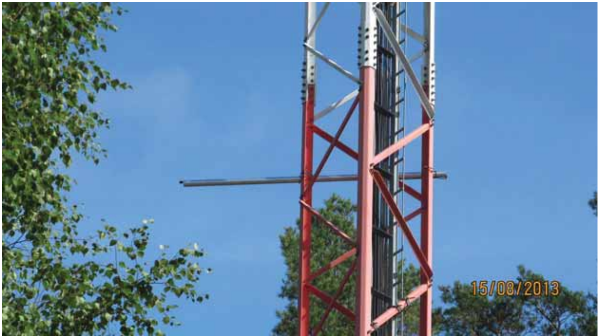
Kuva 3. Nordanån GSM-maston alempi mikrofoni.
