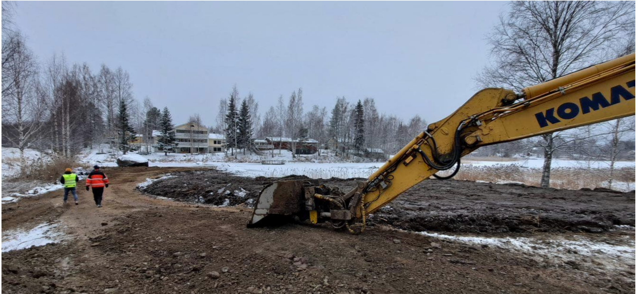
Rautalampi-järven pohjapadon rakentaminen (Sanna Katajamäki 2.12.2022)
