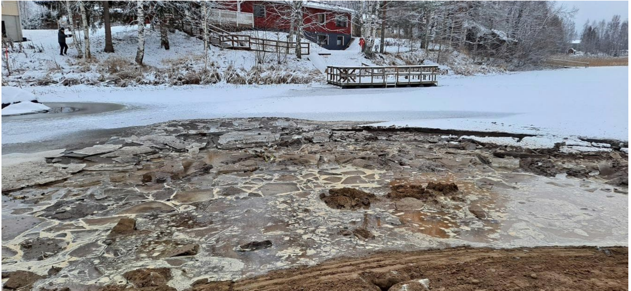
Rautalampi-järven pohjapadon rakentaminen (Sanna Katajamäki 2.12.2022)
