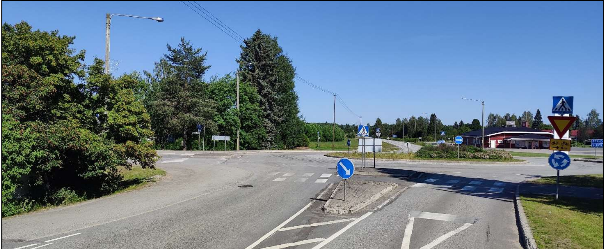
Kuva 27. Seututien 751 ja yhdystien 7511 liittymä Halsualla, näkymä Sillanpään suunnalta.
