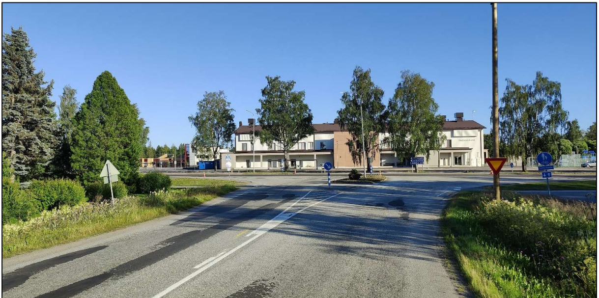
Kuva 13. Seututien 775 ja valtatie 28 liittymä Kannuksessa, näkymä Himangan suunnalta.
