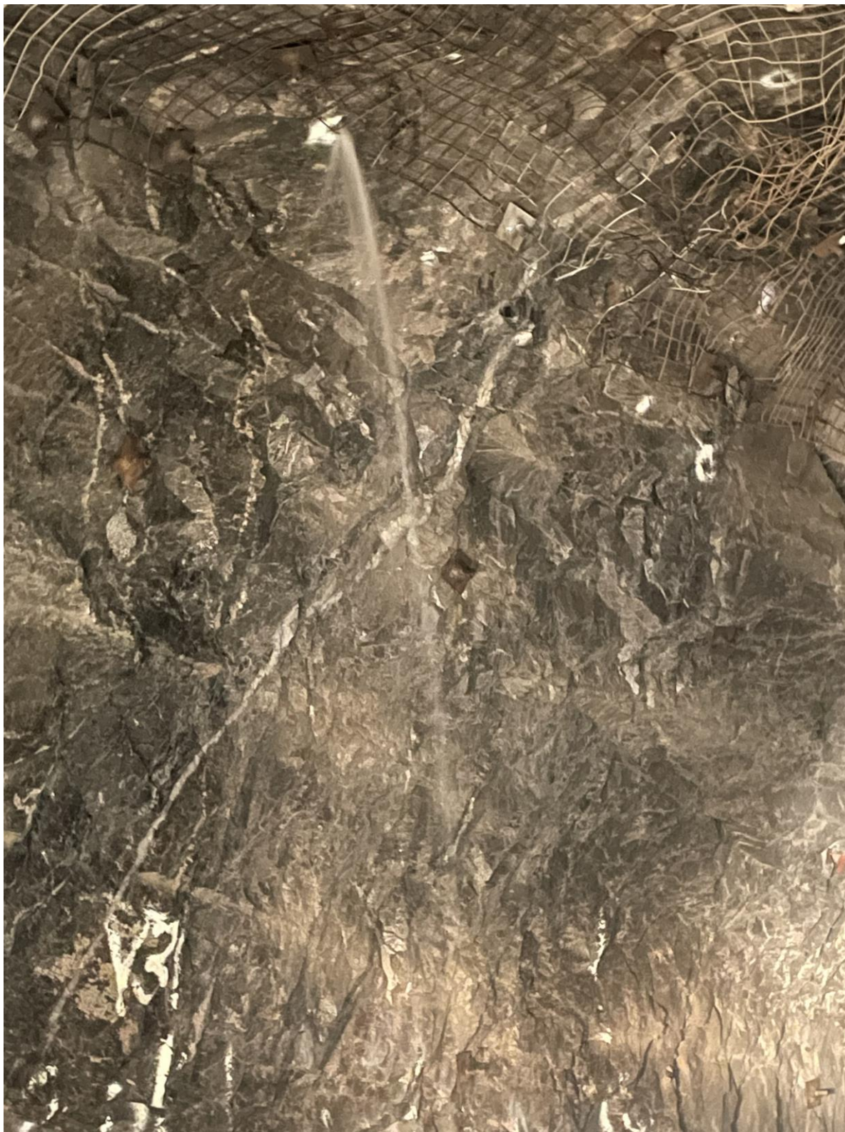
Kuva 4-28. Louhitun tilan katossa kairareikä, josta vuota vettä maanalaiseen kaivokseen.
