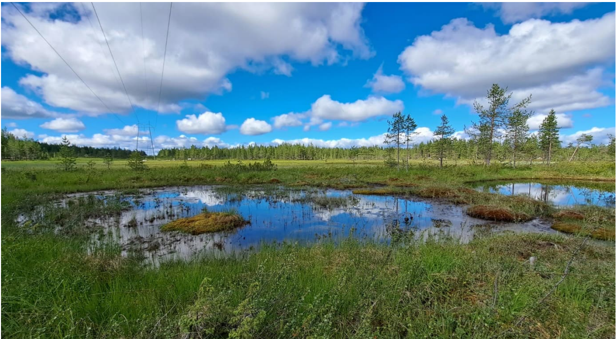
Kuva 6-52. Voimajohto ylittää suolammikoita.
