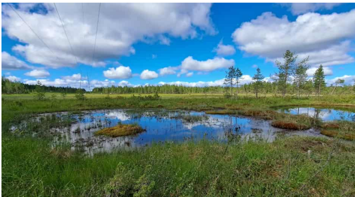
Kuva 6-52. Voimajohto ylittää suolammikoita.
