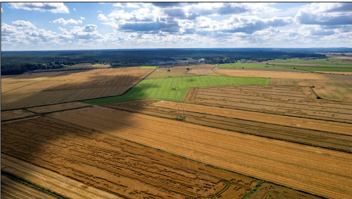
Kuva 3. Voimajohtolinjan eteläpäätä. Seinäjoen sähköasema näkyy taustalla peltojen takana. Kuvauskopterin kuva pohjoisesta. (AKDG7597:28)
