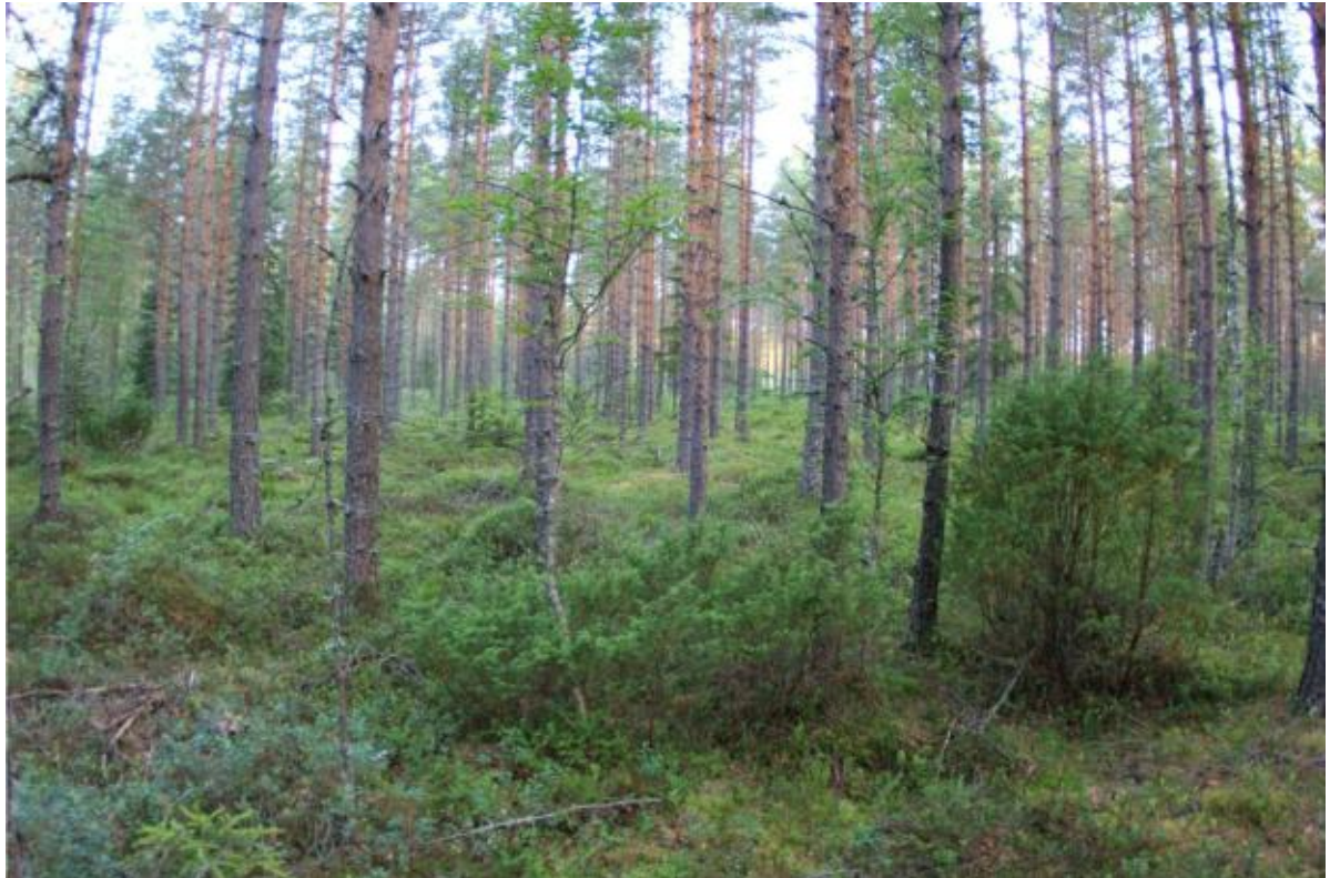
Kuva 10. Näkymää voimalan nro WEA 6H rakentamisalueelta.
