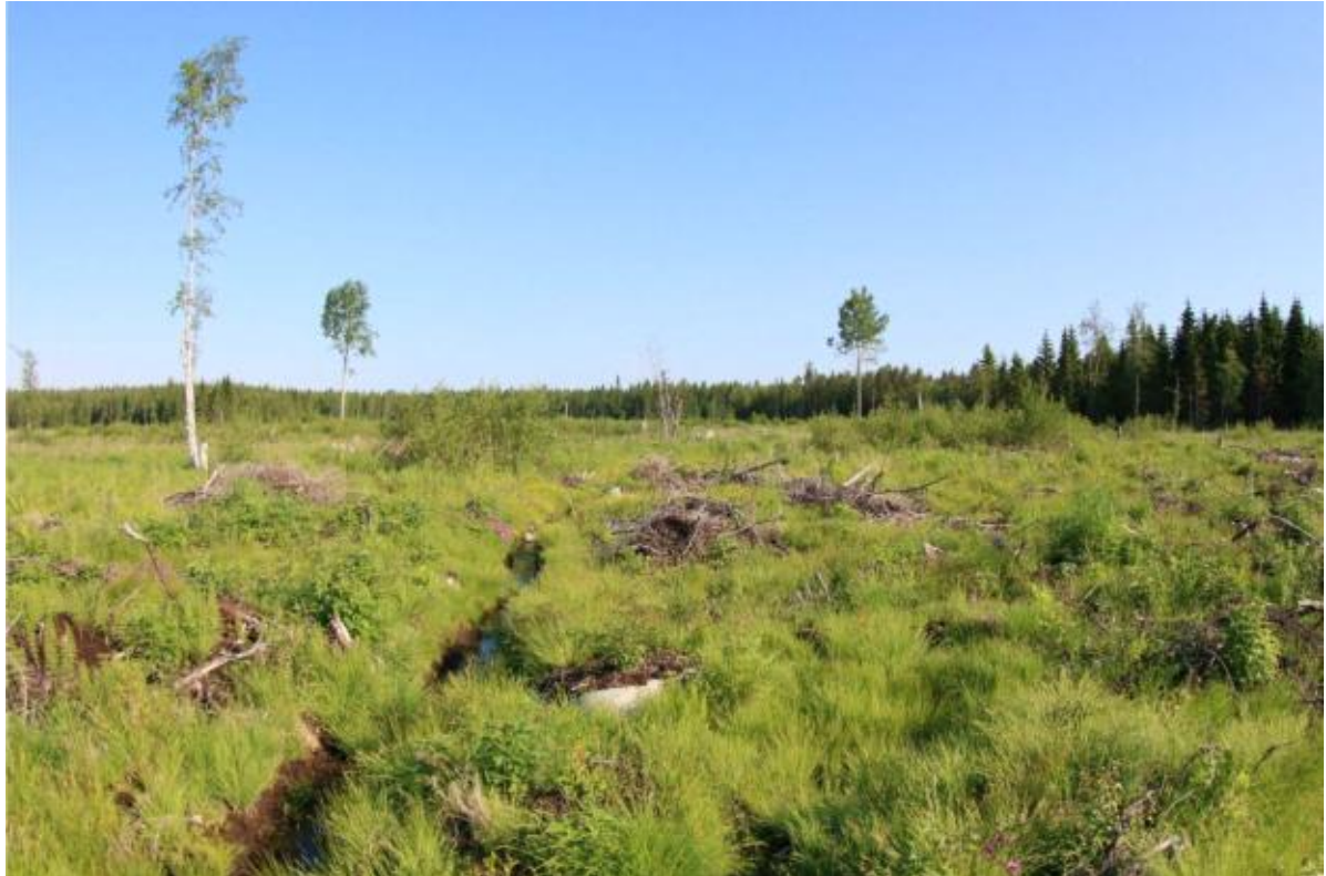
Kuva 28. Voimalan nro WEA 6B rakentamisaluetta.
