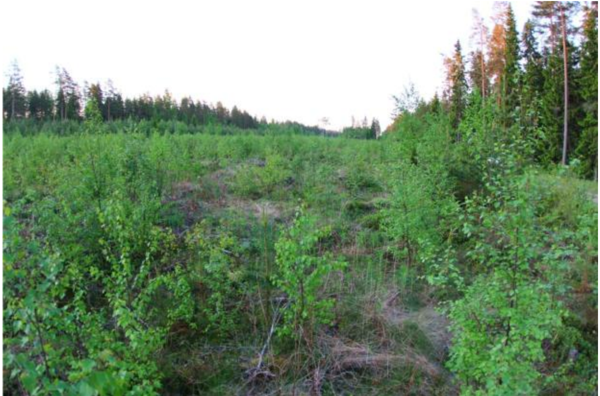
Kuva 6. Voimalan nro WEA 2H rakentamisaluetta.
