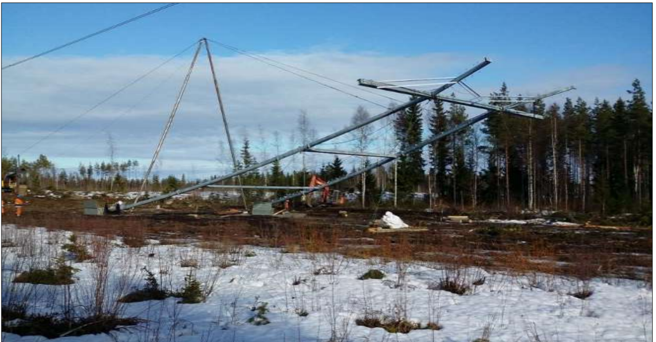
Kuva 7. Voimajohtopylvään pystytys.
