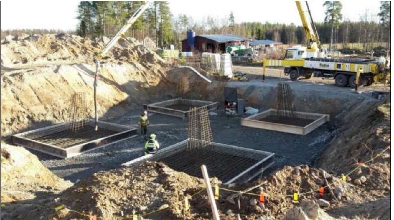
Kuva 6. Vapaasti seisovan pylvään perustuksen pohjatöitä.
