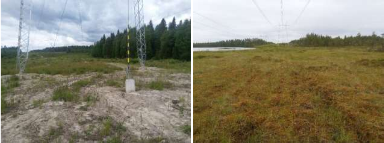
Kuva 8. Pylväspaikoilla kasvillisuus häviää tilapäisesti. Suoalueilla rakentamisesta ei jää juurikaan jälkiä, kun pylvää sijoitetaan mineraalimaan puolelle. Pyhänselkä-Petäjävesi 400 kV voimajohto, noin kaksi vuotta rakentamisen jälkeen.
