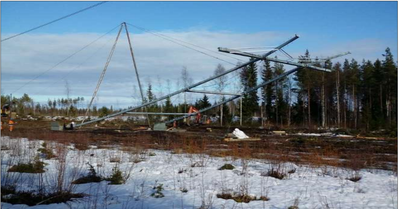
Kuva 7. Voimajohtopylvään pystytys.
